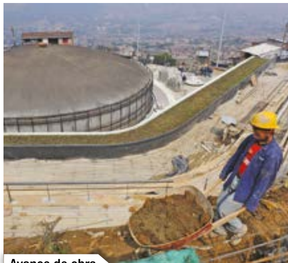
Avance de obra
