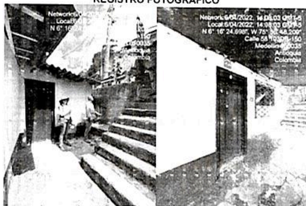
Registro fotográfico Fachada principal de la construcción
