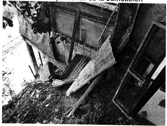
Costado posterior de la edificación
