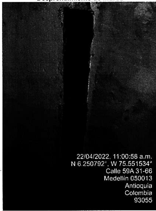
Desprendimiento de muros
