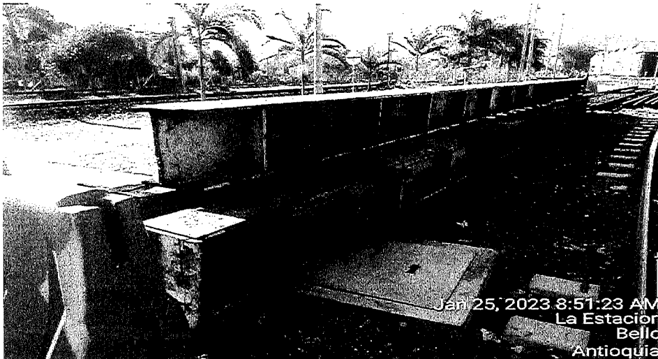
Fotos N°1 y N°2 Panorámicas de las vigas almacenadas en el Metro
