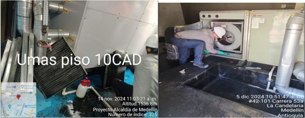
Mantenimiento Centro Administrativo Distrital (CAD) Comuna 10 – La Candelaria Secretaría de Suministros y Servicios
