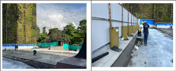
Mantenimiento Centro Administrativo Distrital (CAD) Comuna 10 – La Candelaria Secretaría de Suministros y Servicios
