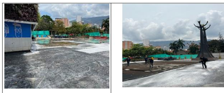
Mantenimiento Centro Administrativo Distrital (CAD) Comuna 10 – La Candelaria Secretaría de Suministros y Servicios
