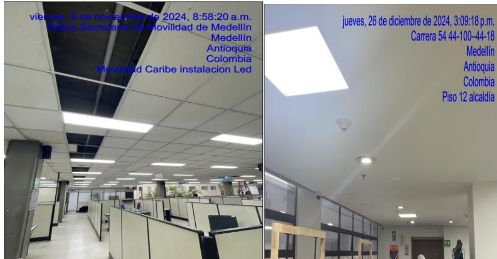
Mantenimiento Centro Administrativo Distrital (CAD) Comuna 10 – La Candelaria Secretaría de Suministros y Servicios
