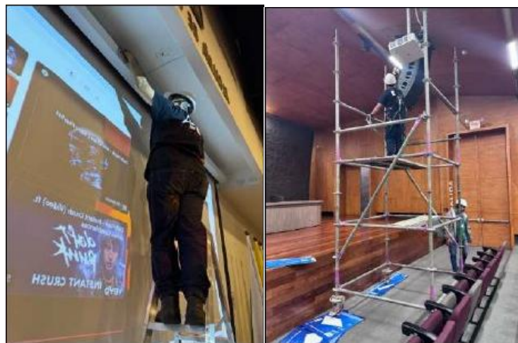
Mantenimiento Centro Administrativo Distrital (CAD) Comuna 10 – La Candelaria Secretaría de Suministros y Servicios
