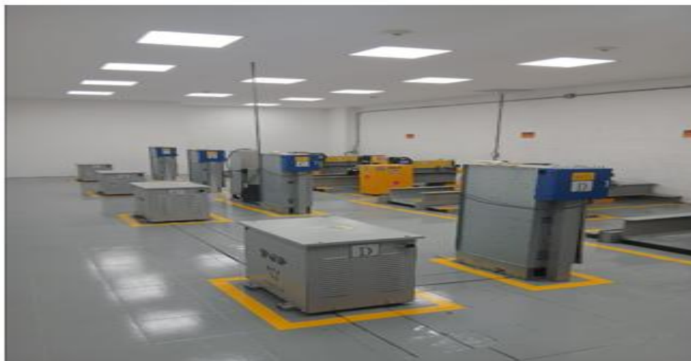
Modernización de ascensores públicos del CAD Comuna 10 – La Candelaria Secretaría de Suministros y Servicios
