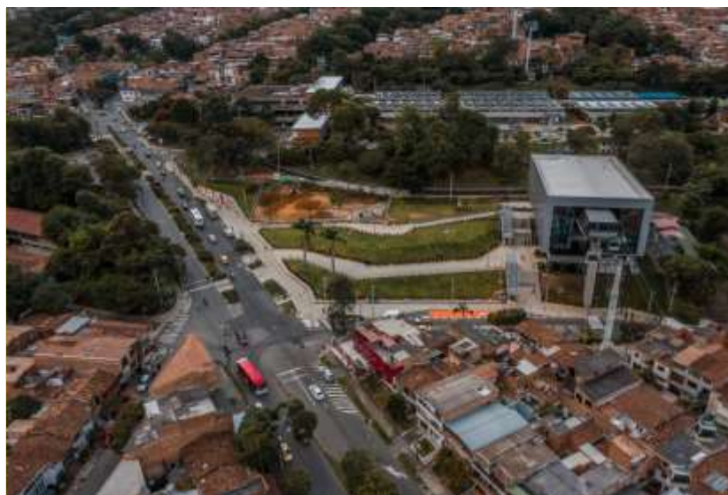
Imagen 9 Paseo Urbano Calle 104 Segunda Etapa Fase 1
