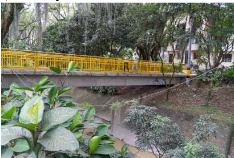
Imagen 30 Puente Peatonal Belén
