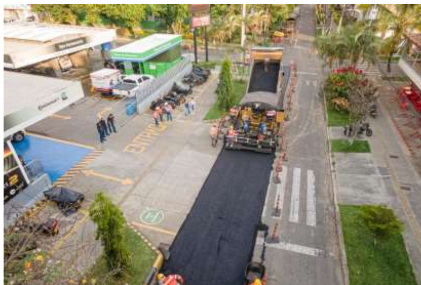
Imagen 25 Aplicación de mezclas tibias en el sector de Los Colores
