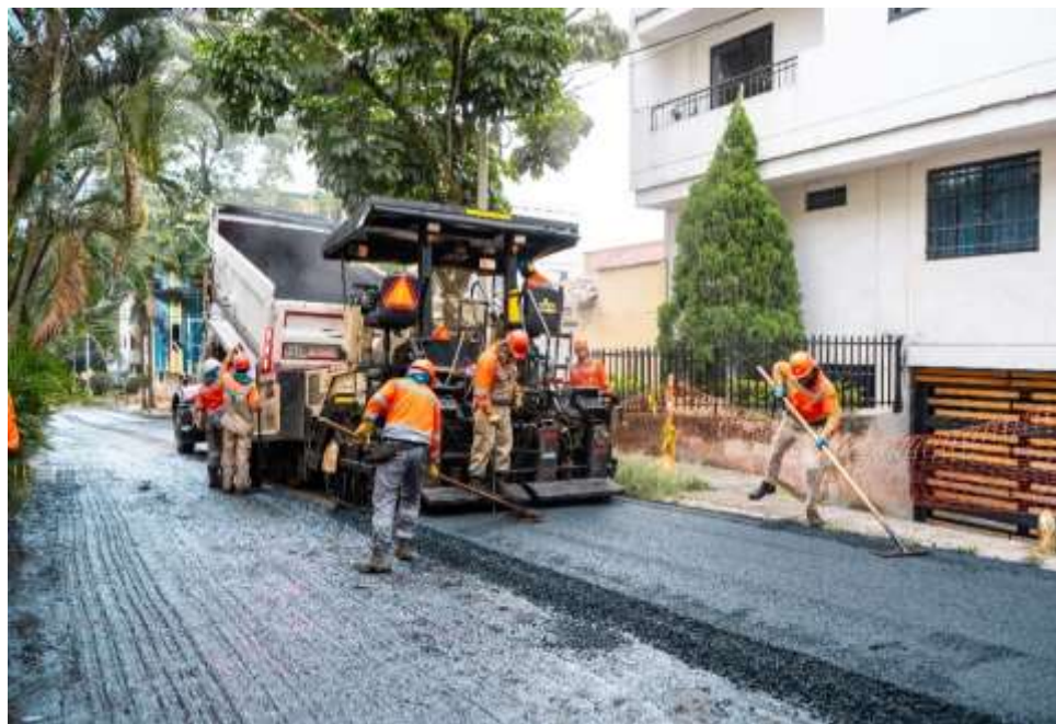
Imagen 24 Intervención malla vial, sector Los Alpes
