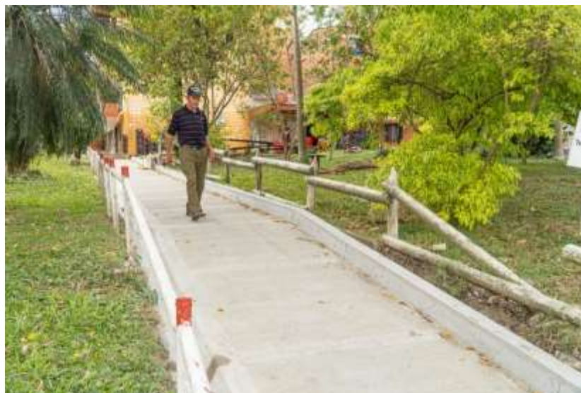
Imagen 17 Andenes construidos Barrio Córdoba
