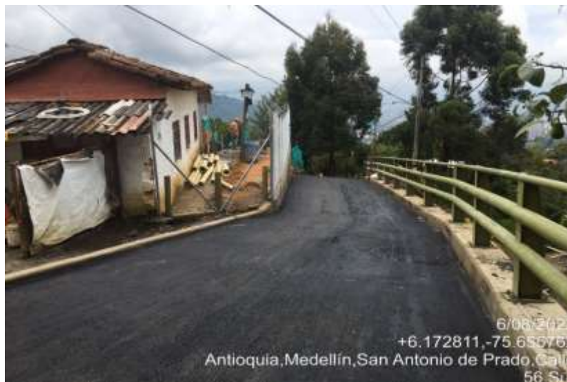
Imagen 34 Obra de contención sector El Vergel - San Antonio de Prado
