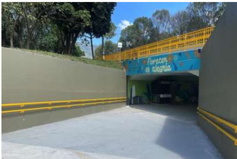
Imagen 4 Soterrado de conexión peatonal con Estación Metro Aguacatala
