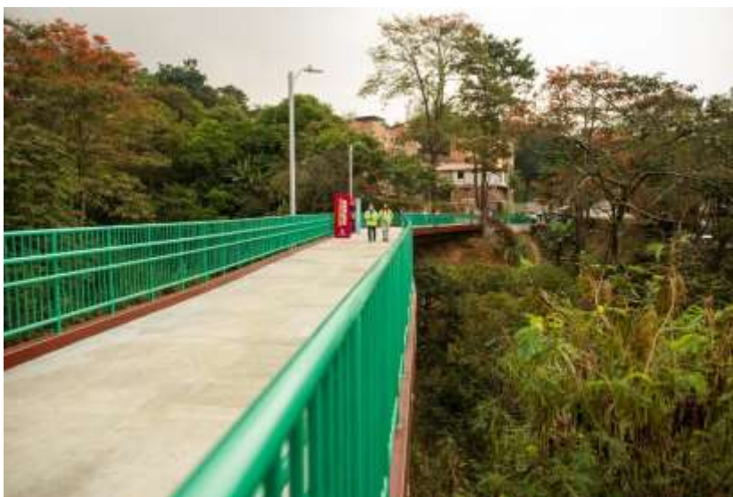
Imagen 28 Puente peatonal La Honda
