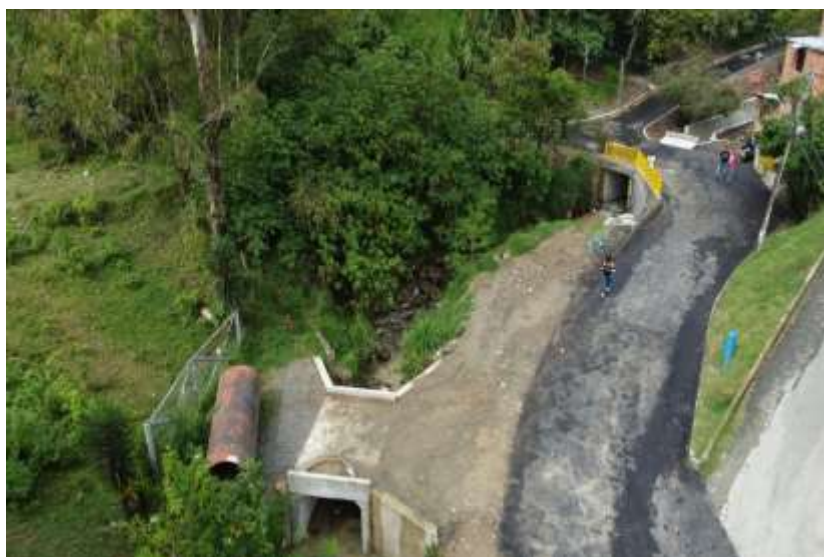
Imagen 33 Obra de contención Sector Monteverde – Altavista
