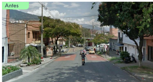
Figura 56 Antes corredor carrera 92. Adaptado de PIMSMed por Departamento administrativo, Alcaldía de Medellín 2020
