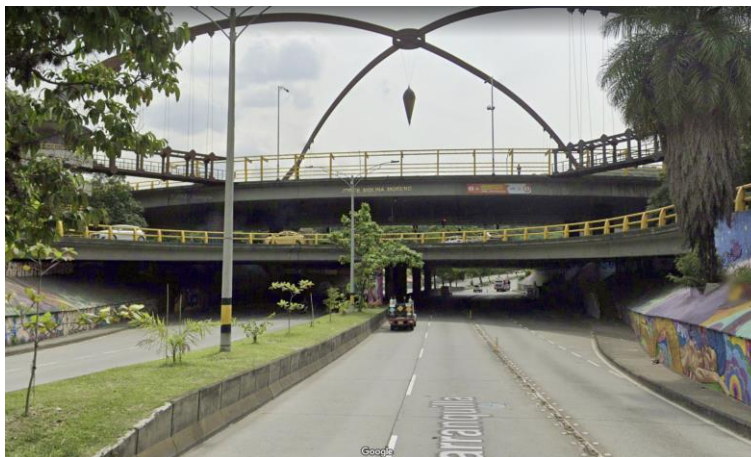
Figura 19 - Punto crítico No 3. Calle 67 con carrera 64C (Glorieta Punto Cero)
