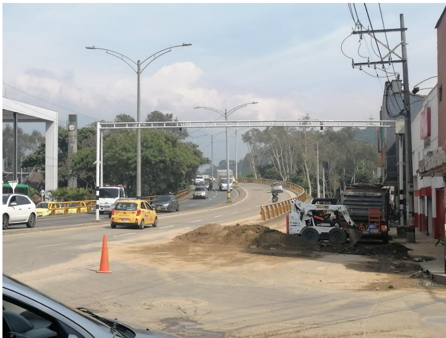
Ilustración 3 alta concentración de grava y material de arrastre.
