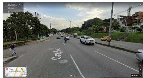
Tramos de andenes y escaleras sin continuidad en la dirección de las líneas de deseo.
