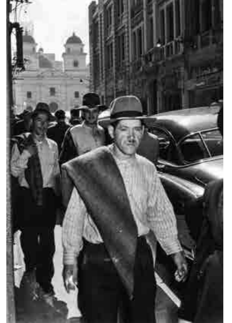
➤ Caminando por el centro de Medellín, c.1950.
