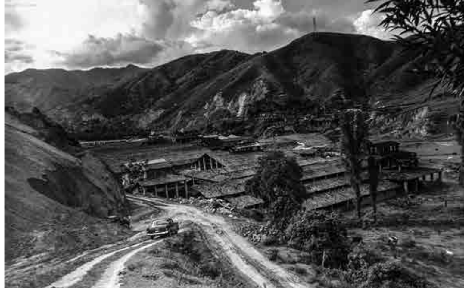
↳ Ladrillera y alfarera Buena Vista, 1970.
