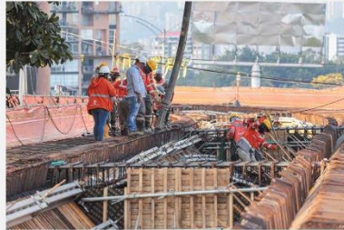
Etapas de ejecución
