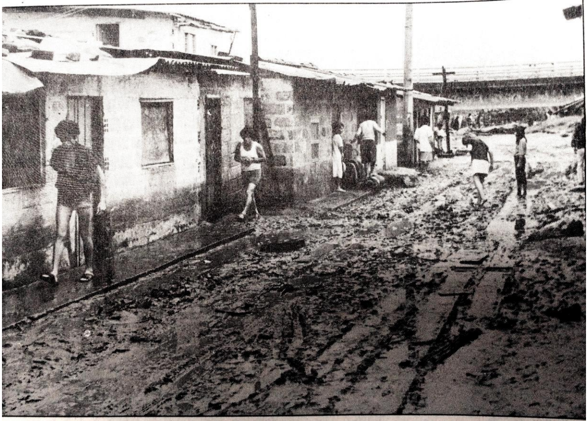
Ilustración 37. Lodo y suciedad.
