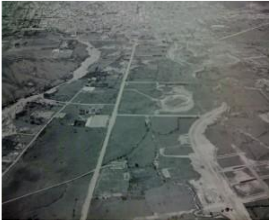
Ilustración 18. Construcción del estadio, 1953.
