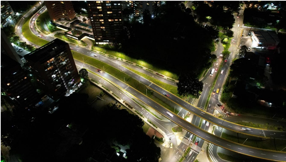
Ilustración 4. Ampliación de la segunda calzada avenida 34 entre la AV43a y la carretera las palmas - Tramo Los Balsos
