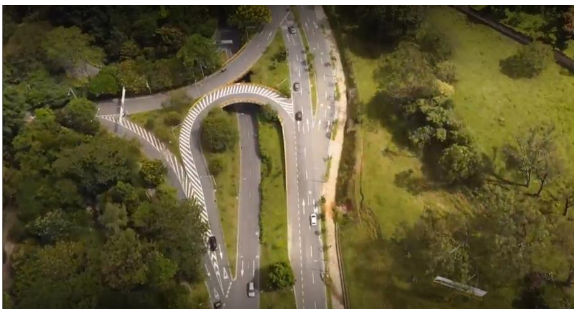
Ilustración 5. Ampliación de la segunda calzada Avenida 34 entre la AV43a y la carretera las palmas - Tramo Aguacatala – Balsos.
