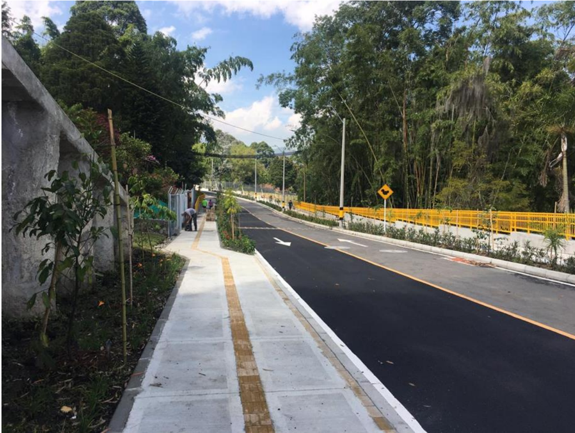
Ilustración 2. Obra prolongación carrera 15 (san lucas – santos marcos de la sierra).
