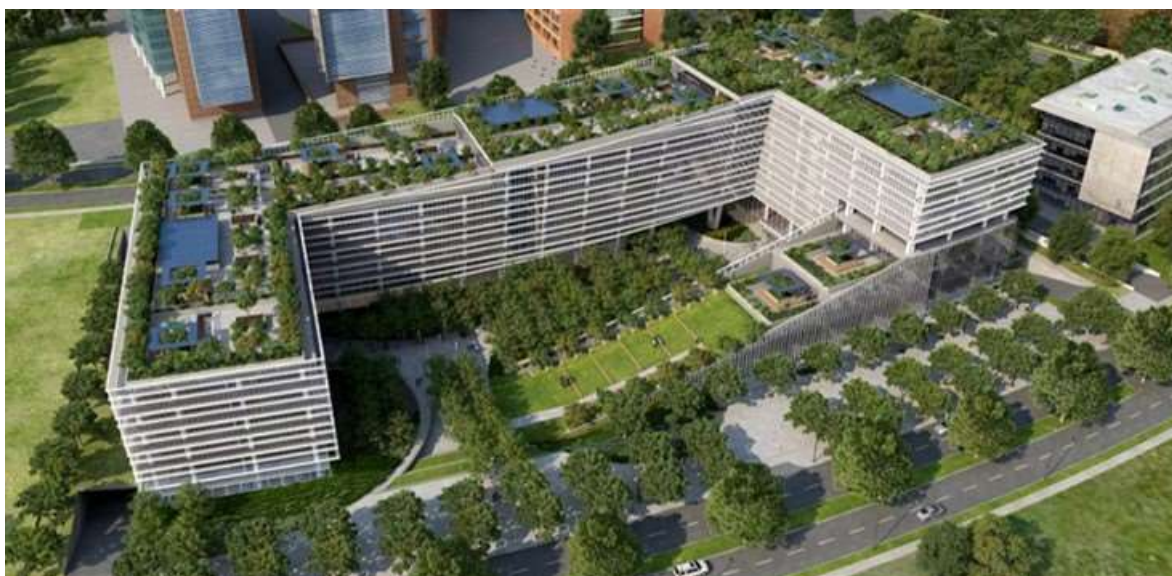
Imagen 3. Techos verdes en construcciones verticales. Fuente: EcoHabitat. 2018.
