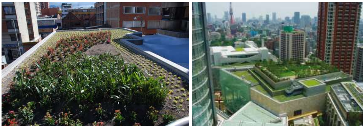
Imagen 2. Ejemplo de techos verdes o cubiertas vegetalizadas (Derecha: imagen EcoHabitat, 2015. Izquierda: techo verde en SDA Bogotá). Documento técnico de soporte SUDS, Alcaldía Mayor de Bogotá – Secretaría Distrital de Ambiente, 2011 y EcoHabitat 2015.
