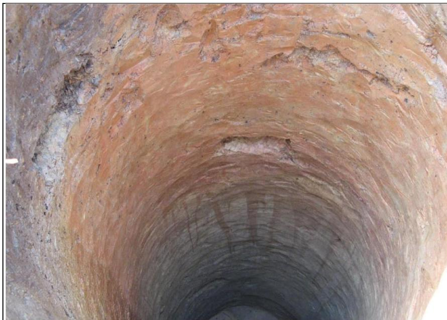
**Foto 2 - Evidencia de afloramiento de aguas infiltradas superficialmente**
