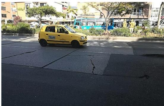
**Registro fotográfico 1. Falla en el pavimento (fisuras) en dirección norte sur de la carrera 46.**
