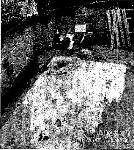
Foto 6: Humedades en losa de cubierta de tercer nivel
