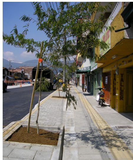
Calle 30, adecuación del espacio público terminado y siembra de árboles, marzo 2007
