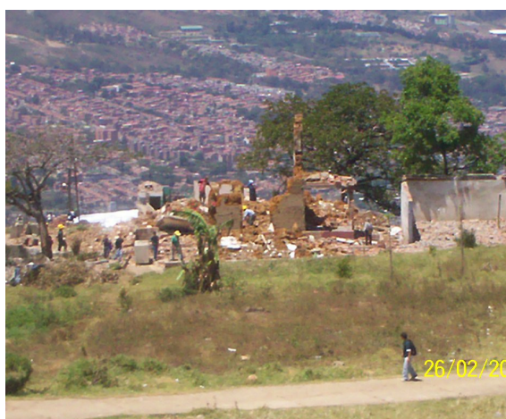
Demoliciones para la construcción del Colegio de Santo Domingo Savio. Febrero de 2007
