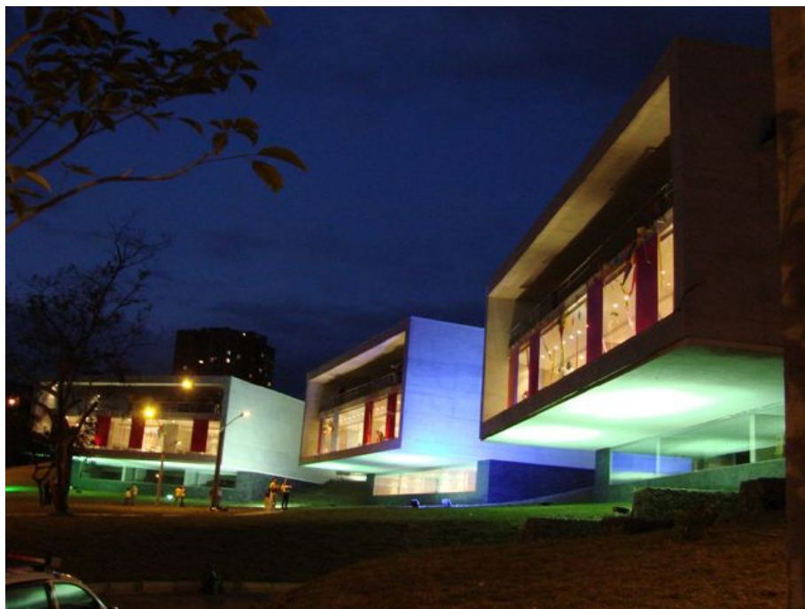
Parque biblioteca León de Greiff en la Ladera. Febrero 2007.
