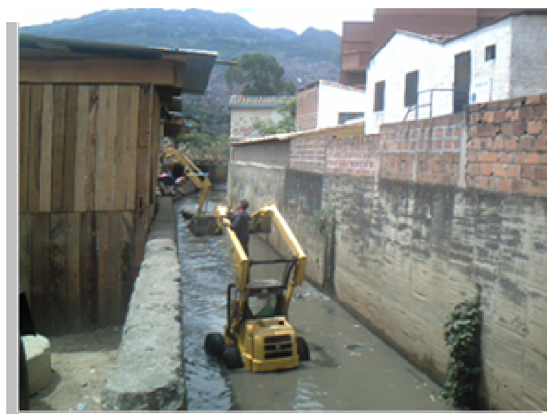
Limpieza de quebrada Bermejala
