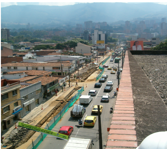
Panorámica de las obras de Recuperación Urbana de la Calle 10 al 23 de febrero de 2007
