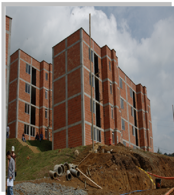
Viviendas Sector Pajarito
