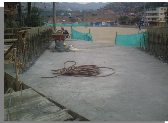
Se termina construcción de puente de calle 85 con 58 FF, se adelantan los puentes de la calle 84(peatonal) y el puente del parque de la Virgen (vehicular)
