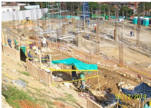
Avance Talleres y cocheras Miraflores a diciembre de 2013
