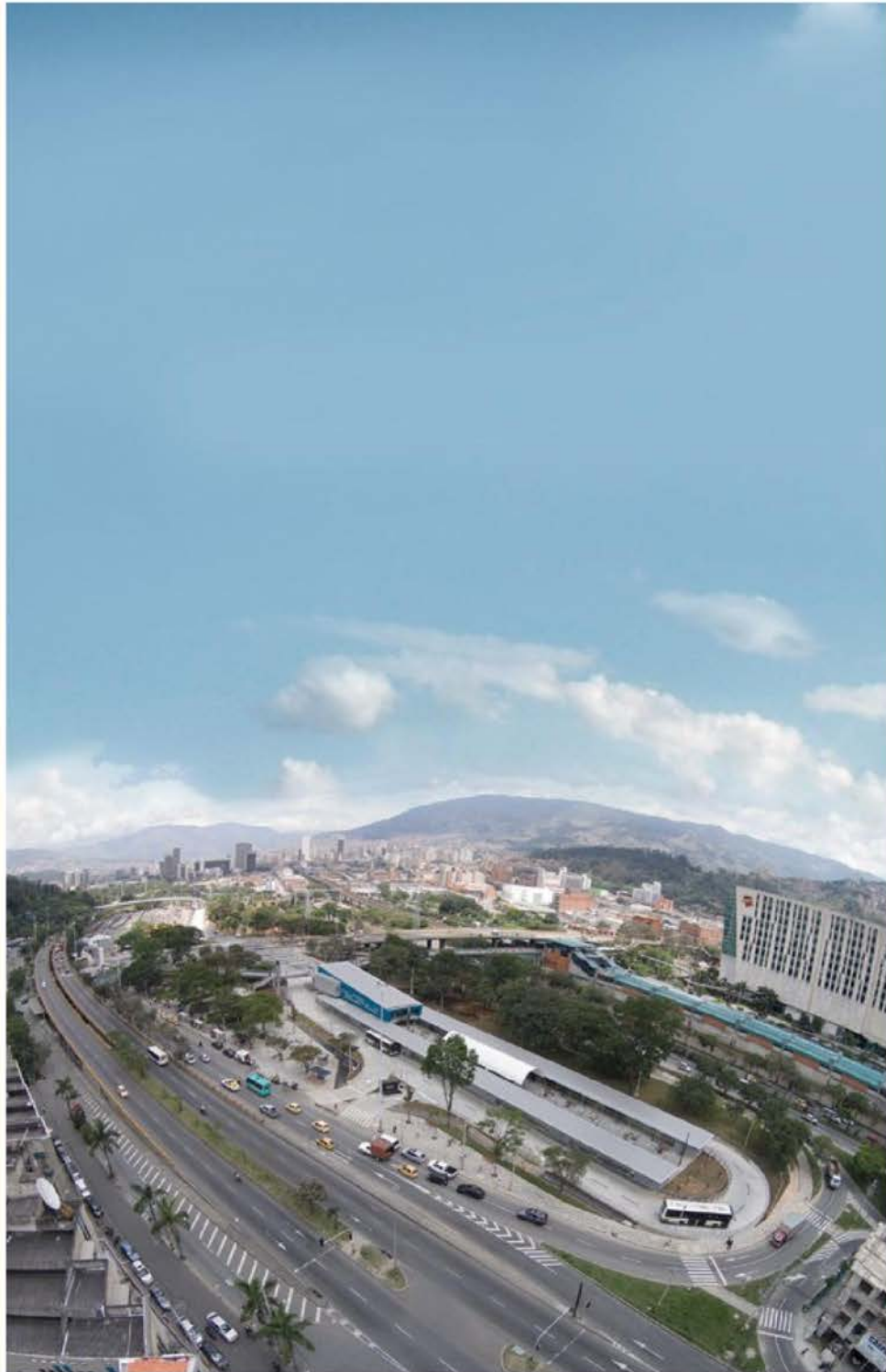
Estación de Intercambio Metroplús Industriales
