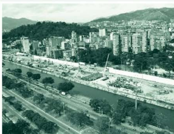
Obras sobre el río Medellín
