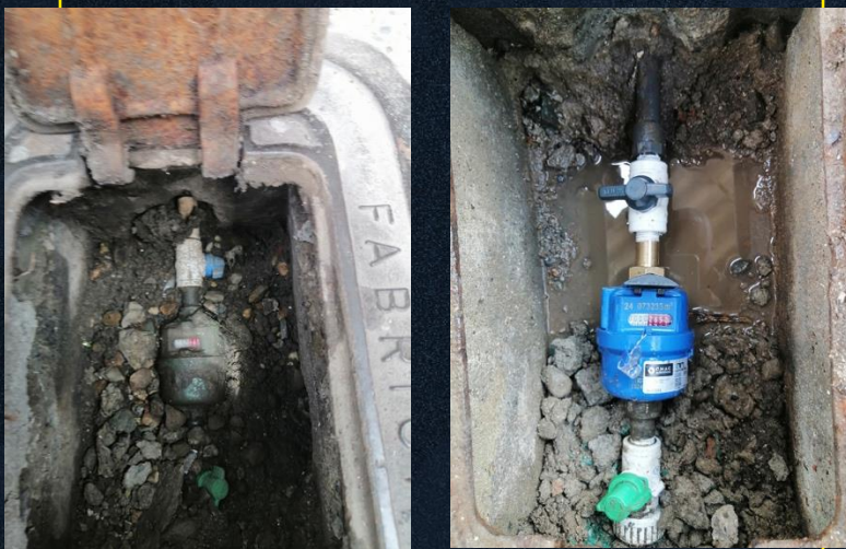
Cambio de micromedidores
