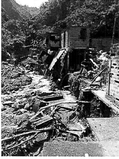
Erosión Margen Izquierda- Quebrada La Seca
