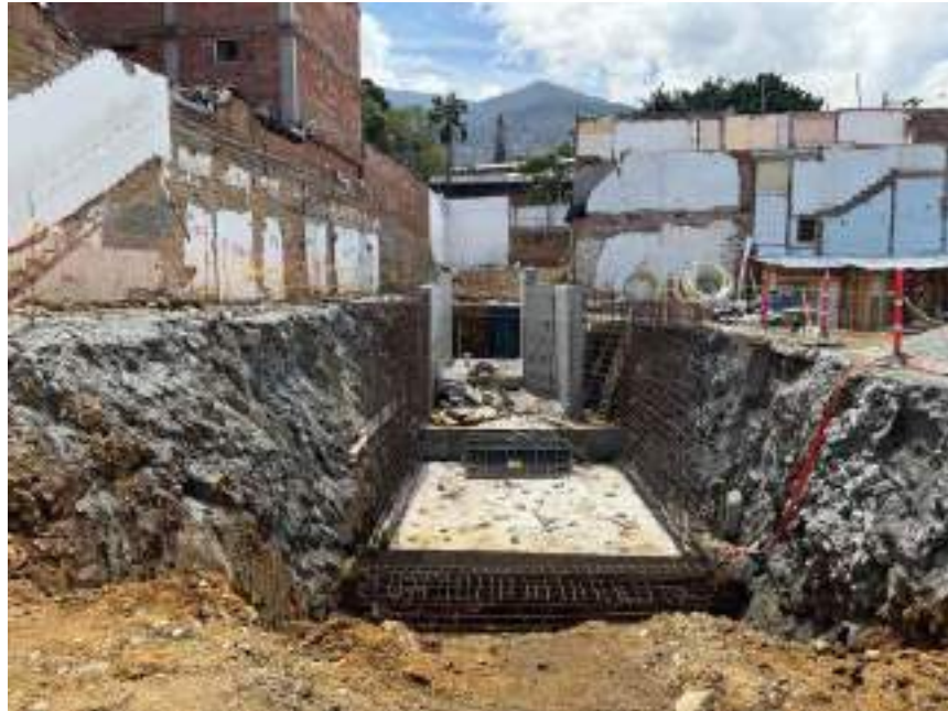
Construcción del canal de la quebrada La Honda. Comuna 3- Manrique. Secretaría de Medio Ambiente.
