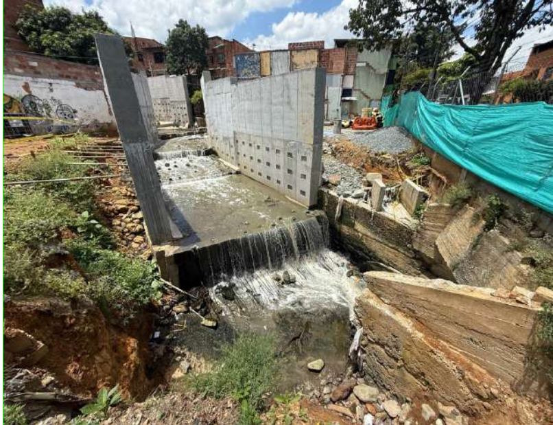
Construcción del canal de la quebrada La Honda. Comuna 4- Aranjuez. Secretaría de Medio Ambiente.
