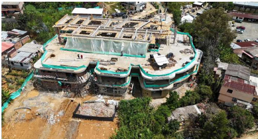
Avance de obra Jardín Infantil Buen Comienzo Chambacú. Corregimiento 60- San Cristóbal.
