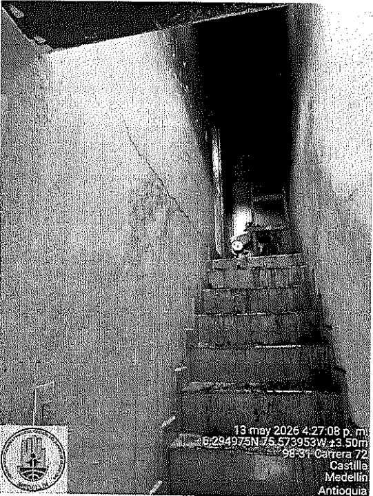
Edificación 1: Escaleras de acceso a tercer nivel interior 301
