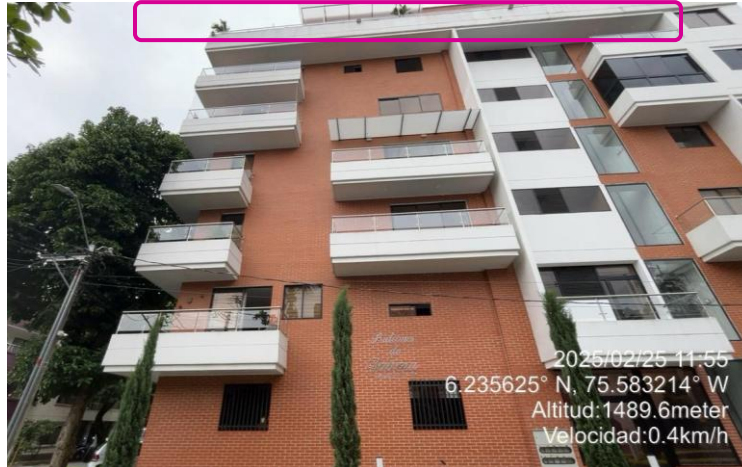
Foto 1. Visita de Control y Vigilancia en la Calle 32A N°65-32, Apto 601 del Edificio Balcones de Fátima, barrio Fátima, comuna 16-Belén de Medellín D.E.
