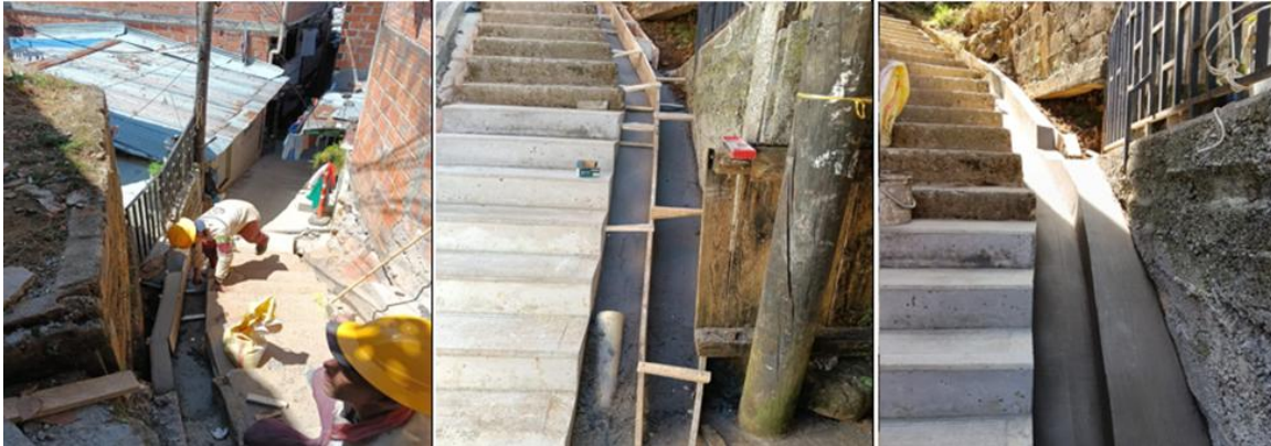
Foto 3. Intervención antes, durante y después. Comuna 8 - Villatina. Abastecimiento Comunitario
