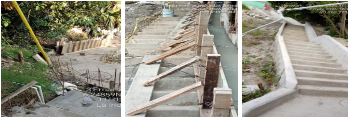
Foto 4. Intervención antes, durante y después. Comuna 13 – Nuevos Conquistadores. Habilitación Vivienda
