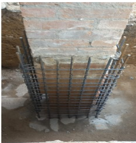
Fotografía 18 Acero de refuerzo figurado.
