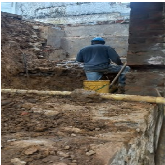
Fotografía 22 Suministro e Instalación de Tubería en PVC 4"
