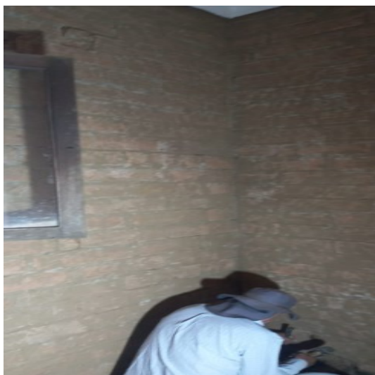
Fotografía 26 Demolición Revoque.
