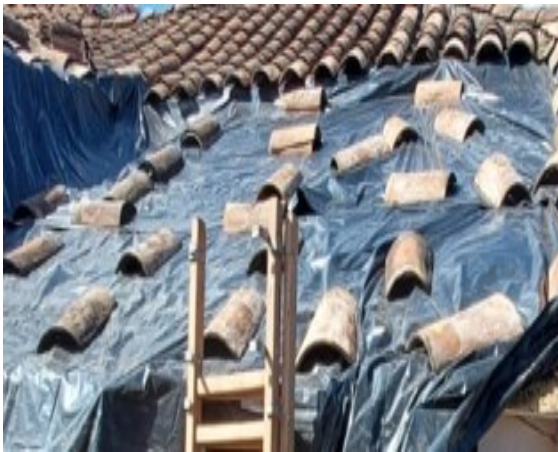
Fotografía 10 Mano de obra retiro y selección de teja existente.
