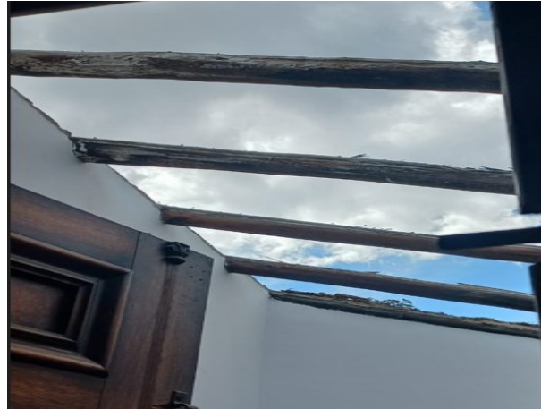
Fotografía 11 Mano de obra retiro cubierta.
