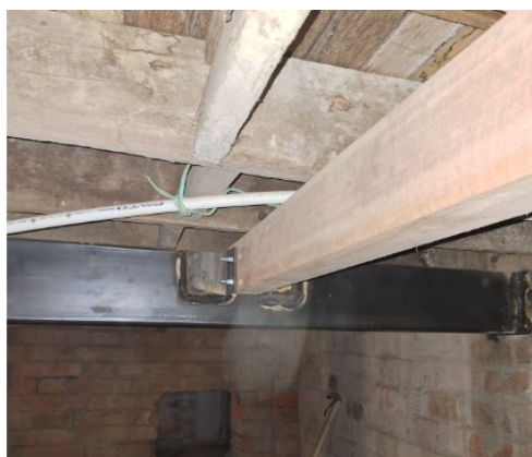
Fotografía 16 Reforzamiento estructural piso central (salón principal y estudios 1 y 2).
