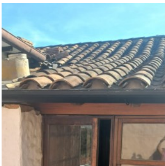
Fotografía 14 Mano de obra instalación teja existente y suministro e instalación de material faltante.
