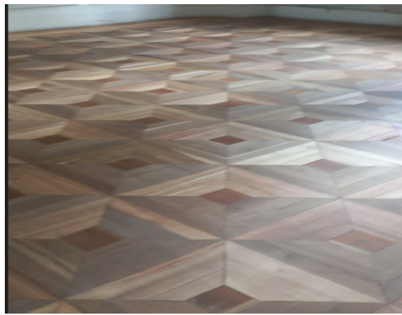
Fotografía 9 Mano de obra destroncada y pulida de madera.
