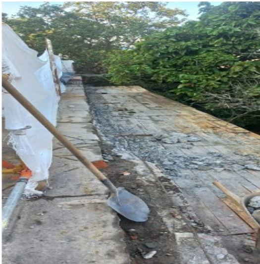
Fotografía 28 Demolición de Viga.
