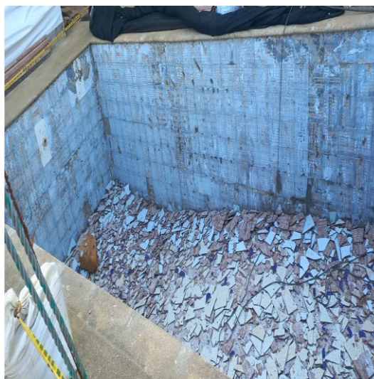
Fotografía 27 Demolición Enchape.
