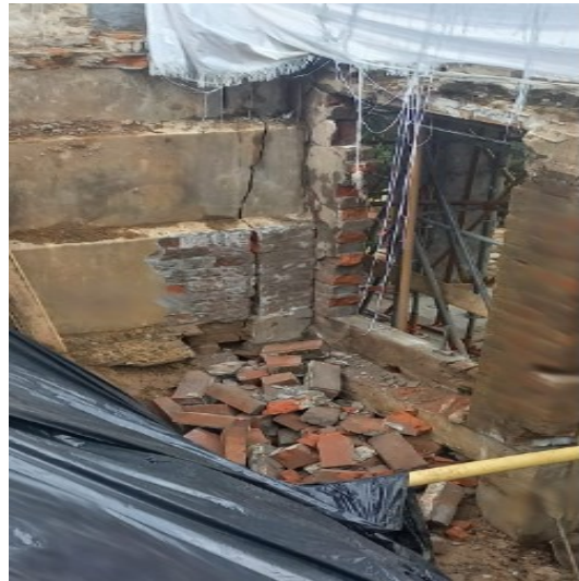
Fotografía 29 Demolición Mampostería en Bloque-
