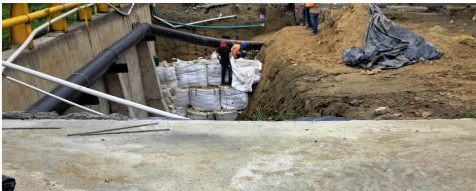
Ejecución de apoyo tubería acueducto para evitar el aumento de la deflexión que tiene la misma, desde el momento de la conexión, por la alta presión
