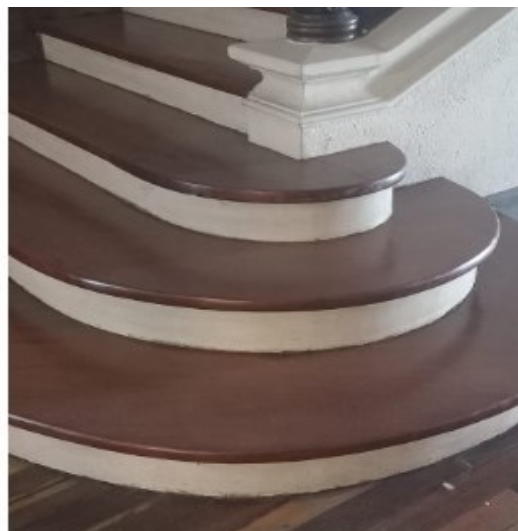
Fotografía 13 Suministro, transporte e instalación de piezas deterioradas o faltantes en piso de canelo
