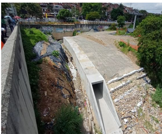
Estado del Box culvert La Herrera.
