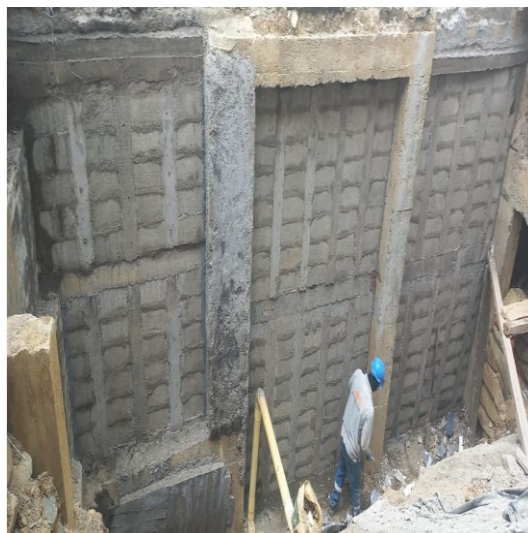
Fotografía 25 Muro de contención.
