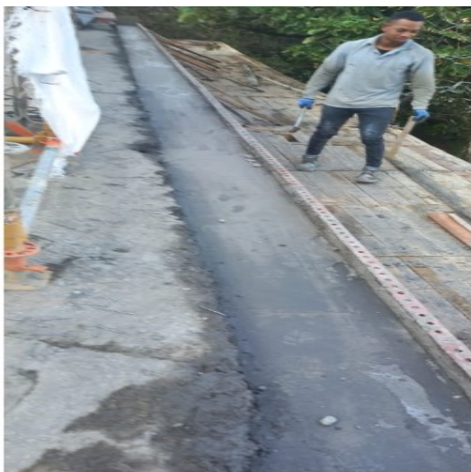
Fotografía 24 Construcción Viga Aérea.
