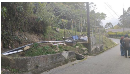
Tanque del acueducto Altavista
