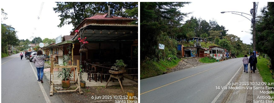
Figura 2-278. Construcciones de uso residencial y comercial en cabecera corregimental Santa Elena.
