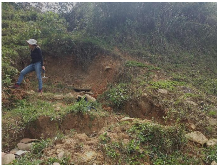
Ilustración 18. Depósito de deslizamiento sobre la vía a Aguas Frías, se observa un sector del escarpe del deslizamiento
