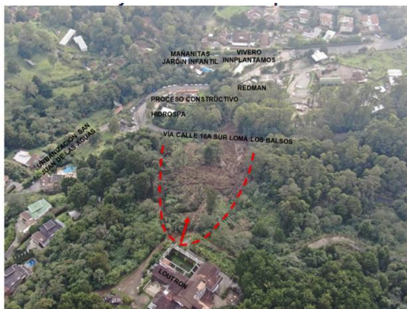
Ilustración 75 Edificaciones localizadas en el área de influencia del movimiento en masa
