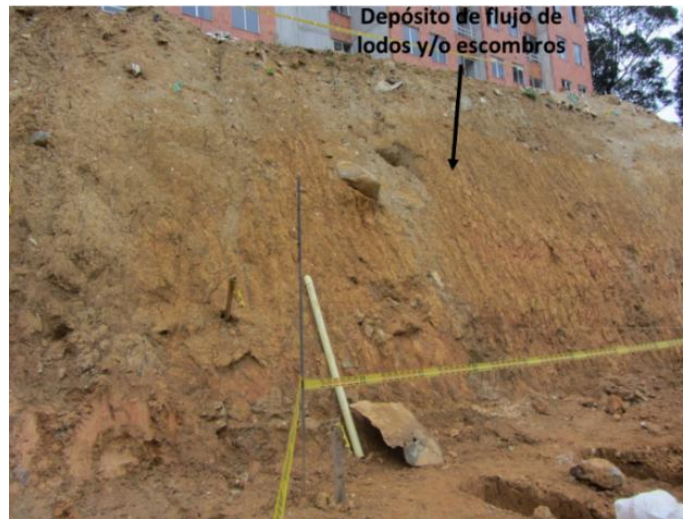
Ilustración 19. Depósitos de vertiente - Flujo de lodos y/o escombros en la urbanización Avellanas
