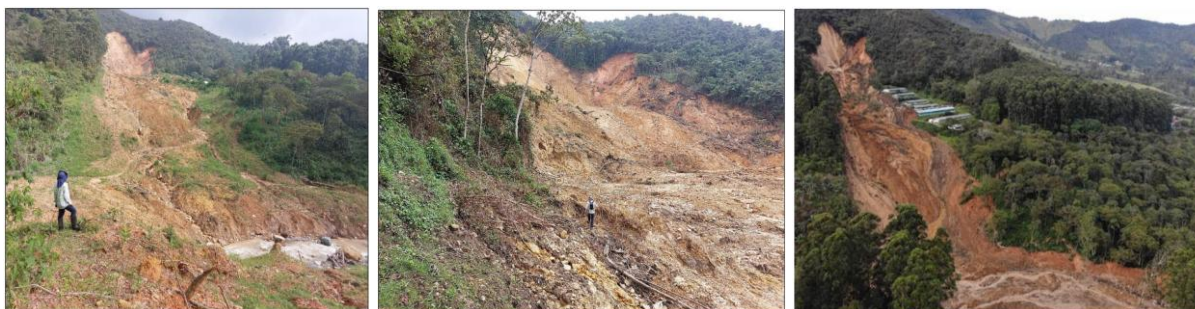
Ilustración 68 Evidencias del flujo observadas durante las inspecciones de campo
