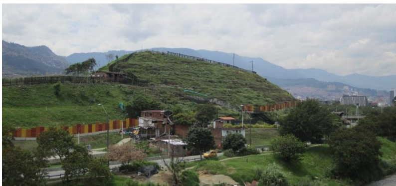
Ilustración 29. Geoforma antrópica relacionado con el relleno sanitario abandonado conocido como cerro de Moravia.
