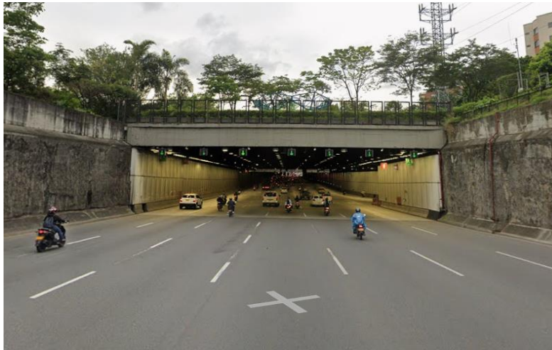
Figura 12 Soterrado “Parques del Río”
