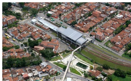
Panorámica de la Centralidad
