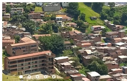
Panorámica de la Centralidad
