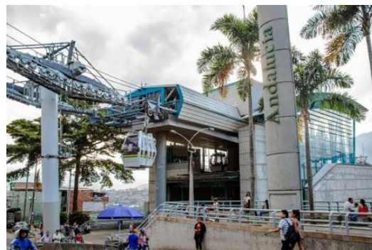
Panorámica de la Centralidad
