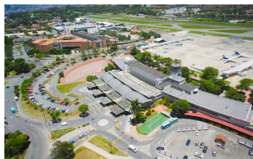
Panorámica de la Centralidad
