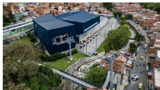
Panorámica de la Centralidad
