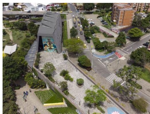
Panorámica de la Centralidad
