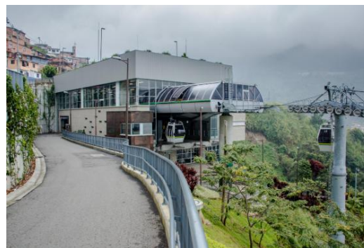
Panorámica de la Centralidad
