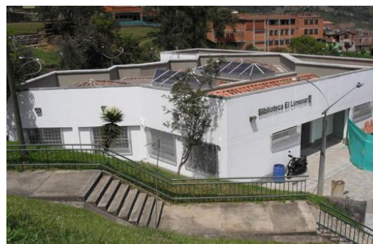
Panorámica de la Centralidad
