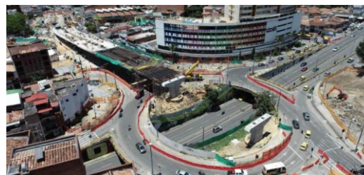
Panorámica de la Centralidad
