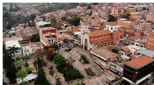
Panorámica de la Centralidad
