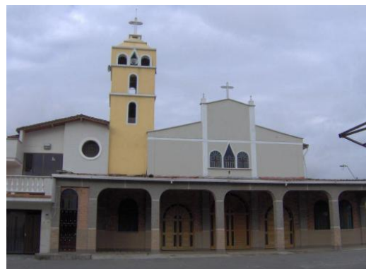
Panorámica de la Centralidad
