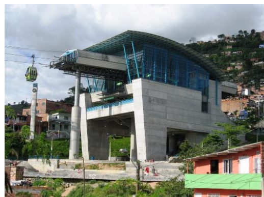
Panorámica de la Centralidad
