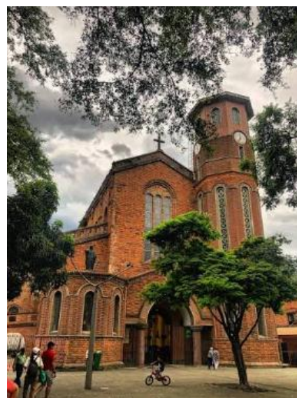
Panorámica de la Centralidad
