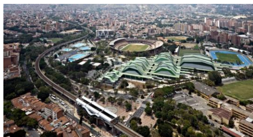
Panorámica de la Centralidad
