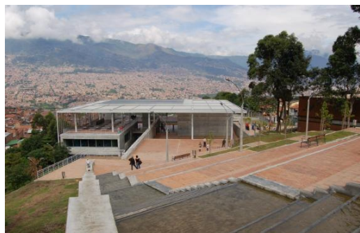
Panorámica de la Centralidad
