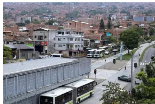
Panorámica de la Centralidad
