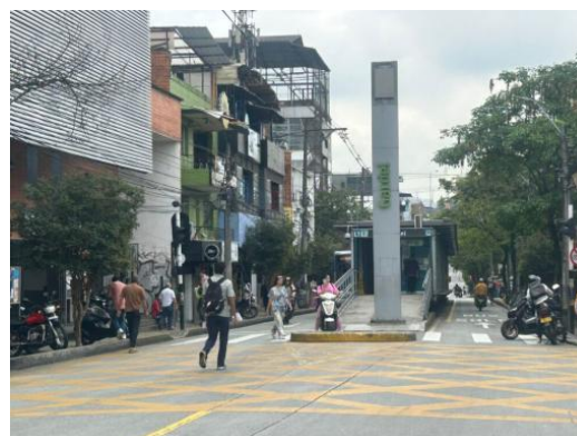
Panorámica de la Centralidad
