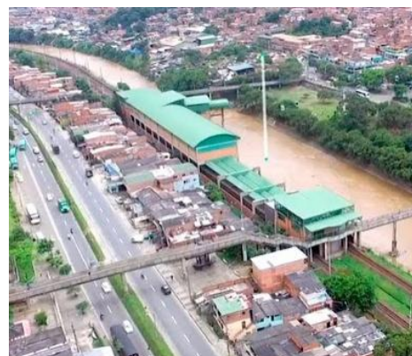
Panorámica de la Centralidad
