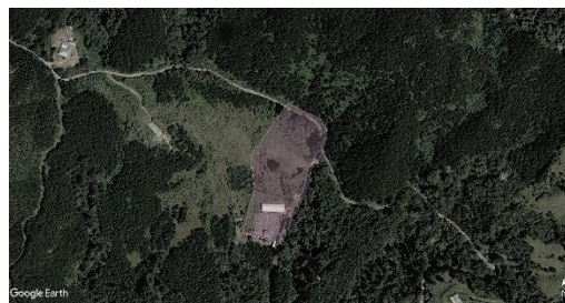
Panorámica de la Centralidad
