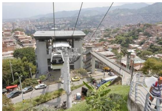
Panorámica de la Centralidad
