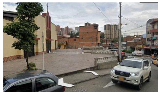
Panorámica de la Centralidad
