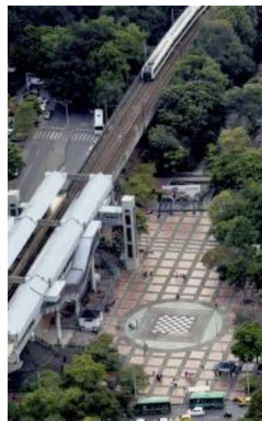
Panorámica de la Centralidad
