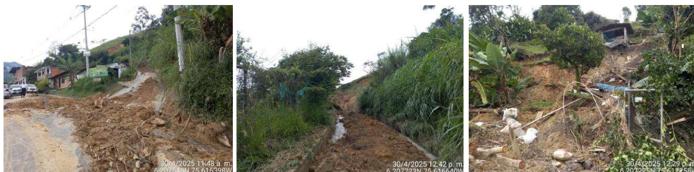
Ilustración 77 Evidencias de las afectaciones del deslizamiento en la vereda El Jardín
