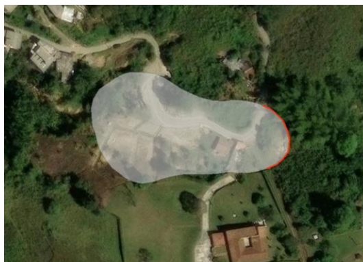
Ilustración 65 Deslizamiento en la vereda La Verde
