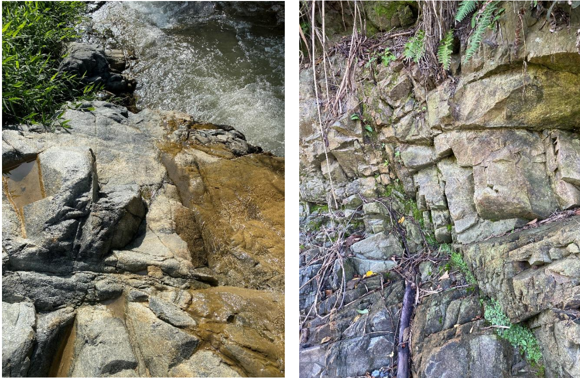
Ilustración 10. Roca fracturada reportada sobre el cauce y margen izquierda de la quebrada La Iguaná
