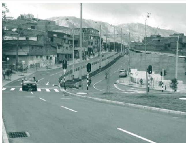
Ampliación de la carrera 65 entre las calles 101 y 103E etapa I
