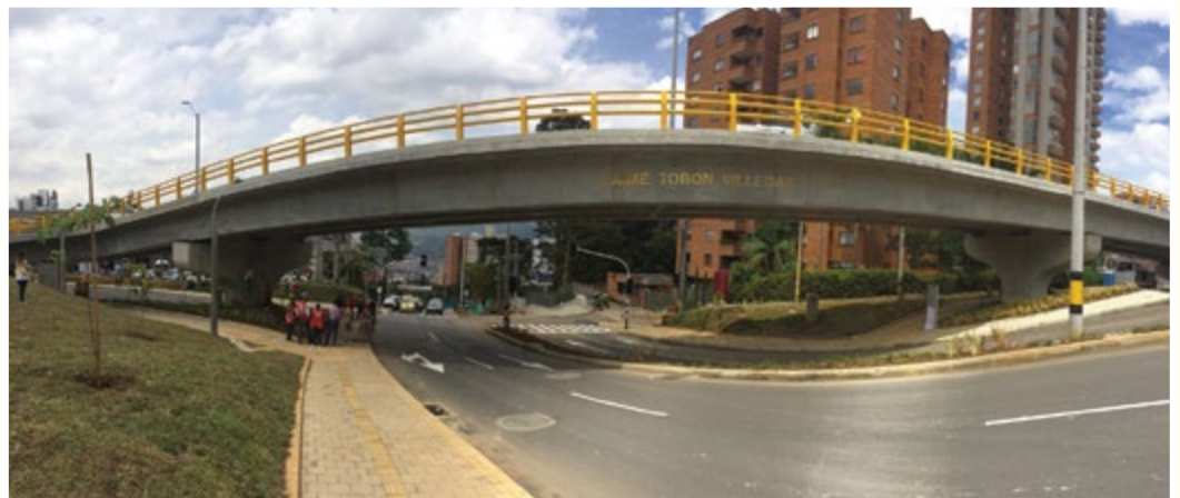
Intercambio Vial Jaime Tobón Villegas (una de las 23 obras de Valorización)
