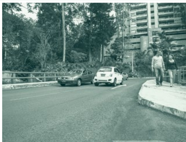
Empalme de la vía Linares a la calle 10
