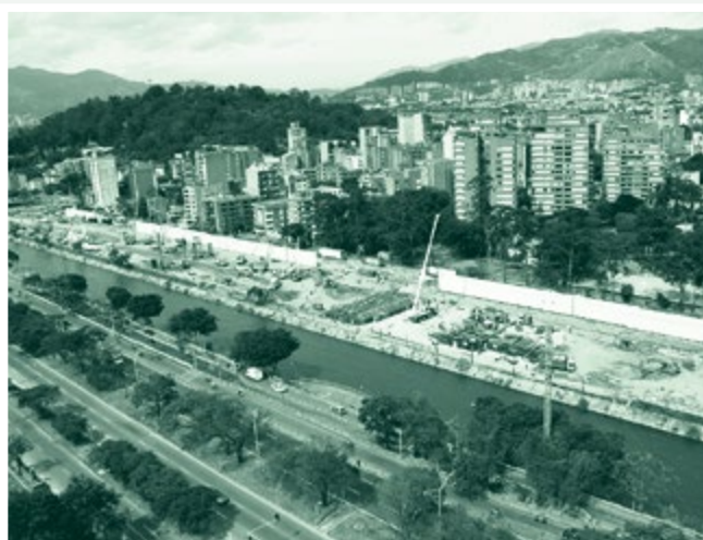
Obras sobre el río Medellín
