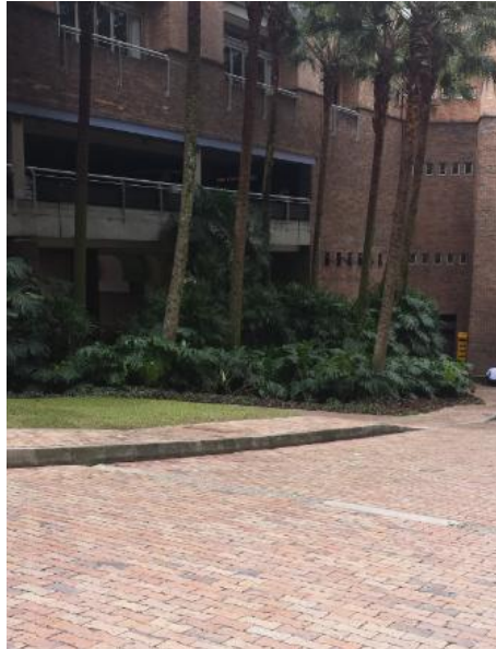
Tramo soterrado al interior del Club Aproximadamente 30 metros - vía interna
