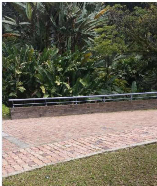
Acceso de la quebrada al lote desde la Av. Las Palmas.
