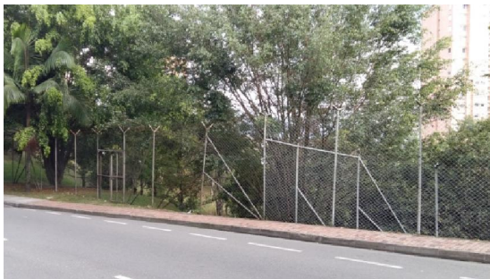
Cerramiento del predio desde la vía Las Palmas
