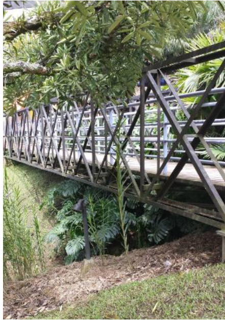
Obra para cruce peatonal
