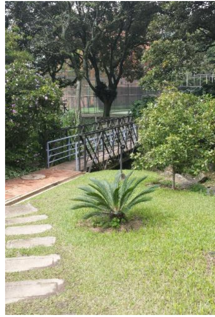
Segunda obra para cruce peatonal
