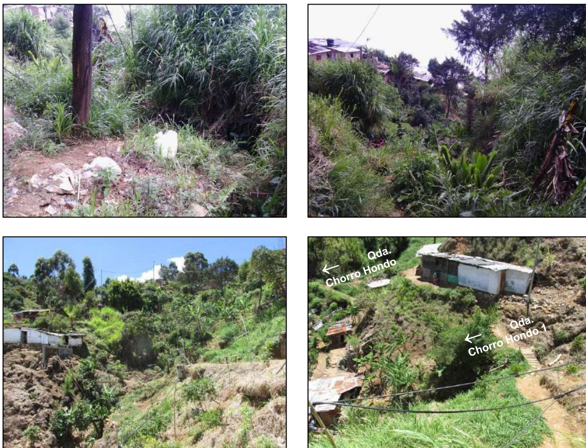
Figura 175. Tramo final en cauce natural de Quebrada Chorro Hondo 1
