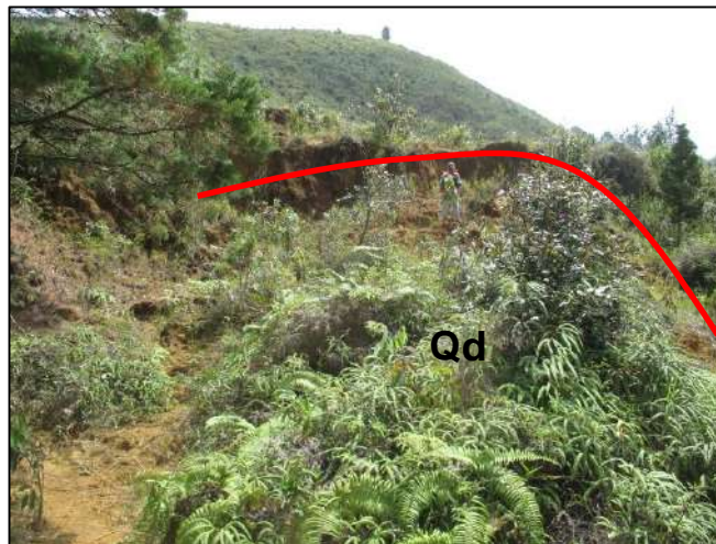
Figura 14. Depósito de deslizamiento en la parte alta de la UMI El Faro-Golondrinas
