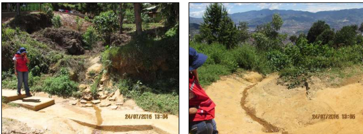
Figura 167. Intercepción del cauce con sendero peatonal ubicado a 40 m desde puente peatonal aguas arriba y batea en concreto ciclópeo
