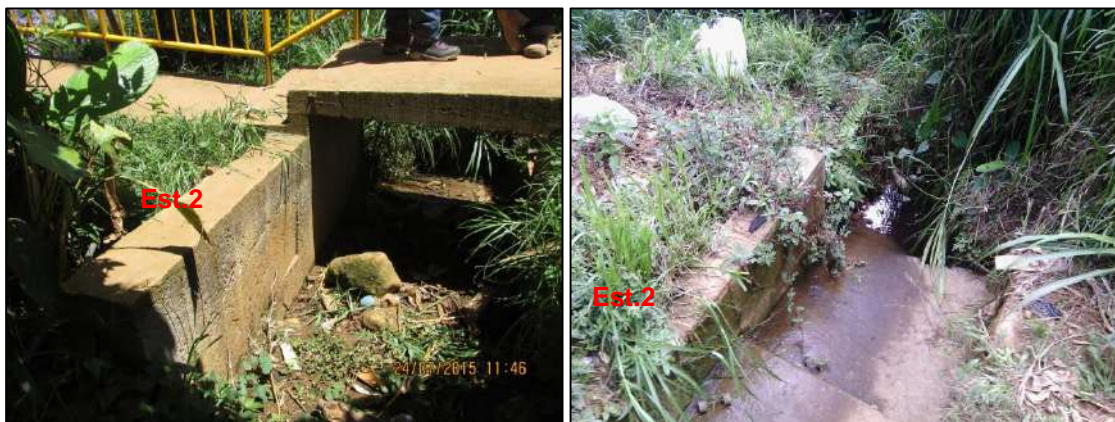
Figura 174. Entrada y descarga de canal en concreto de fondo escalonado (Est.2). Puente Peatonal 2
