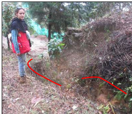
Figura 55. Socavación lateral en la Quebrada Chorro Hondo
