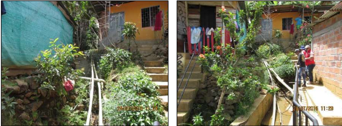
Figura 177. Obstrucción en cauce e invasión por viviendas en la Quebrada Chorro Hondo 1
