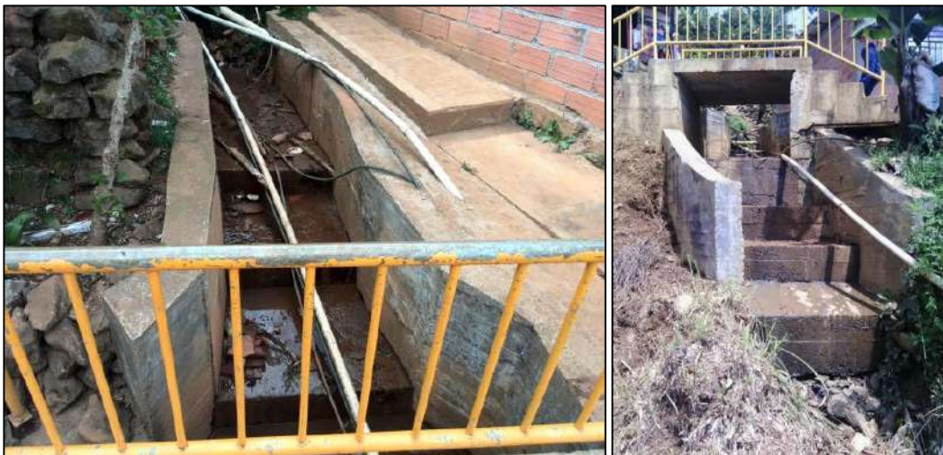
Figura 172. Entrada y descarga de canal de concreto con fondo escalonado (Est.1). Puente Peatonal 1
