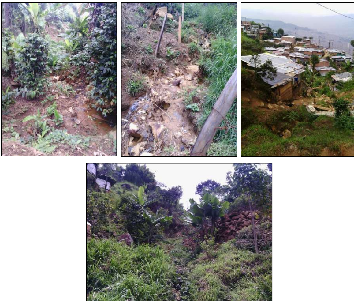
Figura 168. Características del tramo final de la Quebrada Chorro Hondo aguas abajo de batea en concreto ciclópeo
