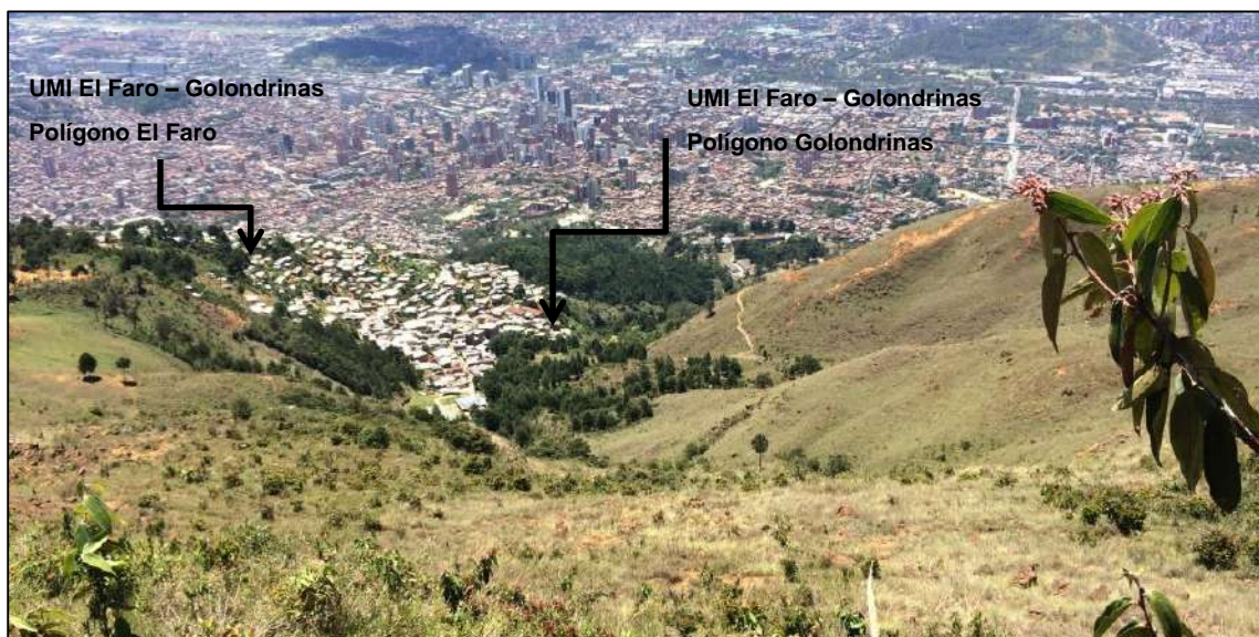
Figura 5. Vista de la parte baja de la Zona 2 de la UMI El Faro - Golondrinas
