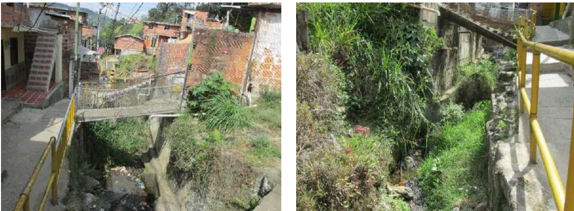
Figura 178. Canal con paredes en concreto y fondo natural. Presencia de viviendas cercana al cauce
