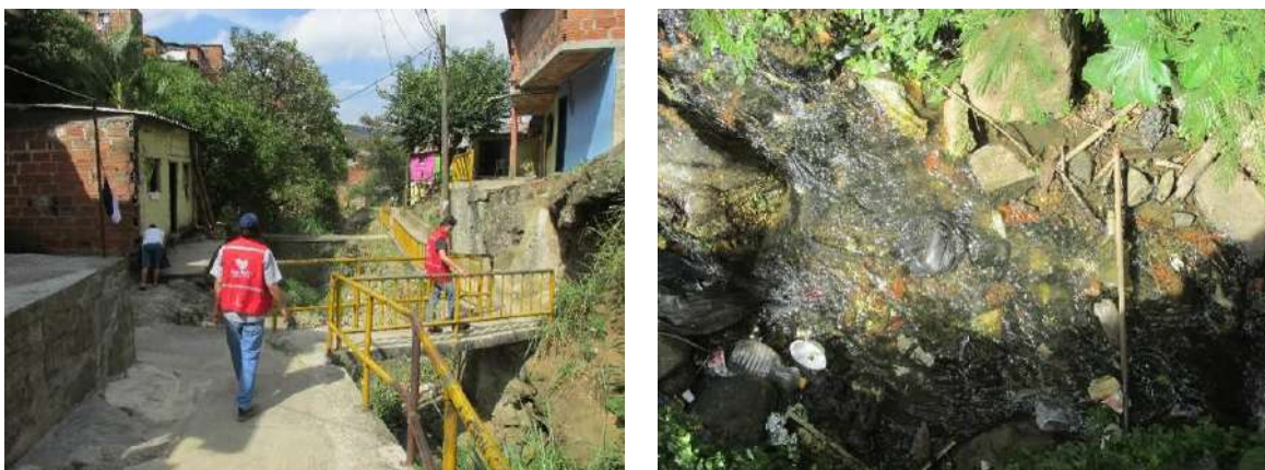
Figura 179. Cambio de sección en cauce, talud natural margen izquierda y muro de contención margen derecha.
