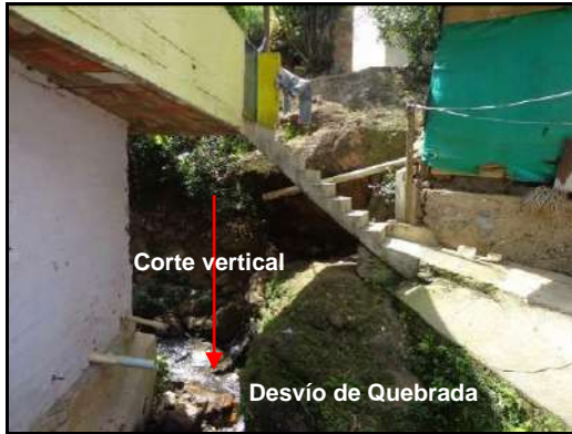
a) Zona de desvío de Quebrada
