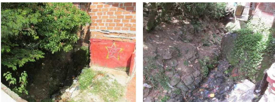
Figura 180. Cambio de sección con márgenes en fragmentos de roca y presencia de viviendas
