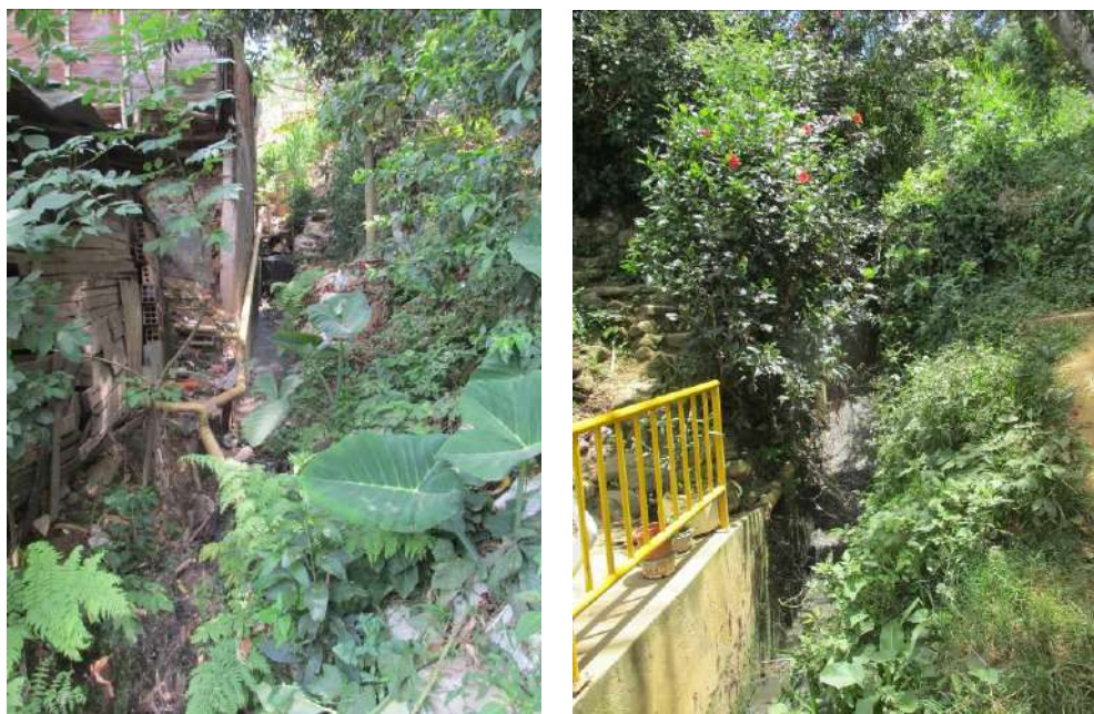
Figura 194. Parte media del tramo analizado de la Quebrada San Antonio que corresponde a un canal natural con presencia de viviendas
