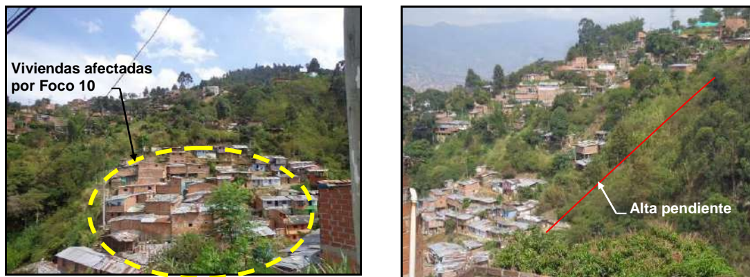
a) Viviendas afectadas por Foco 10
