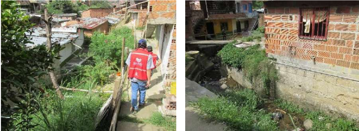
Figura 177. Inicio canal abierto de paredes de concreto y fondo natural con presencia de viviendas cercanas y cámaras de inspección.
