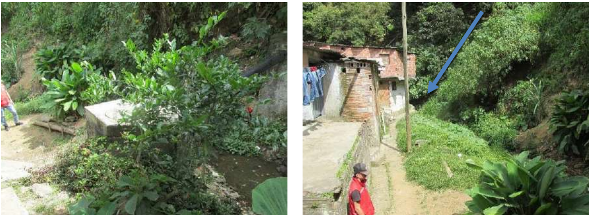
Figura 183. Quebrada La Castro - Tramo 2 y descarga del afluente AF La Castro 1
