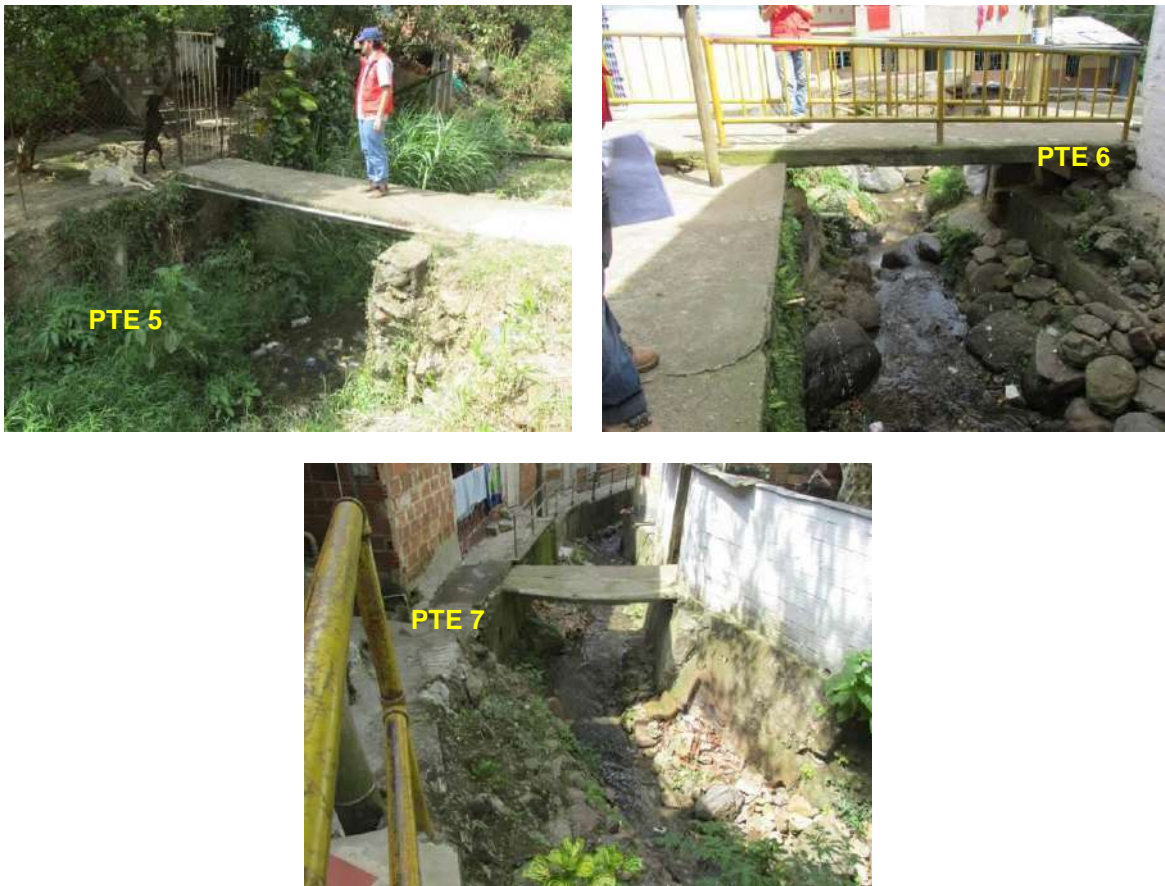
Figura 187. Puente PTE 5 ubicado en el Tramo 1 y puentes PTE 6 y 7 ubicados en el Tramo 2 de la Quebrada La Castro
