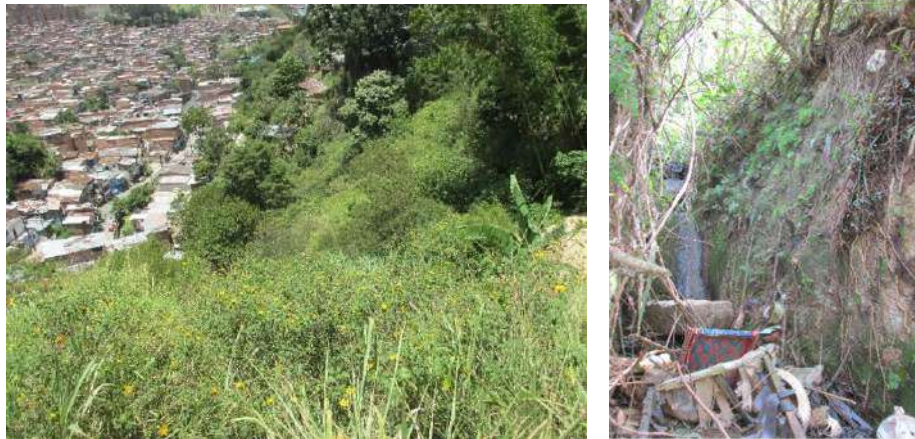
Figura 190. Parte baja del afluente AF La Castro 1
