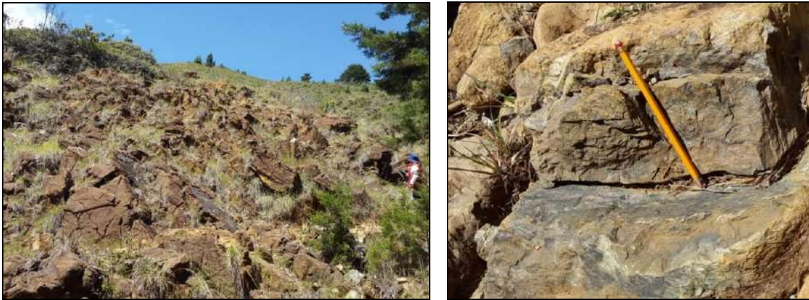
Figura 24. Bloques en superficie por erosión superficial en el Horizonte IIA de meteorización
