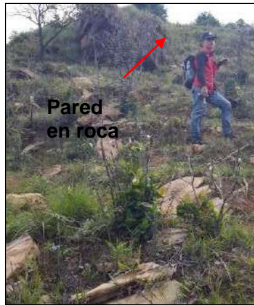
Figura 60. Escarpes de roca con alto grado de fracturamiento
