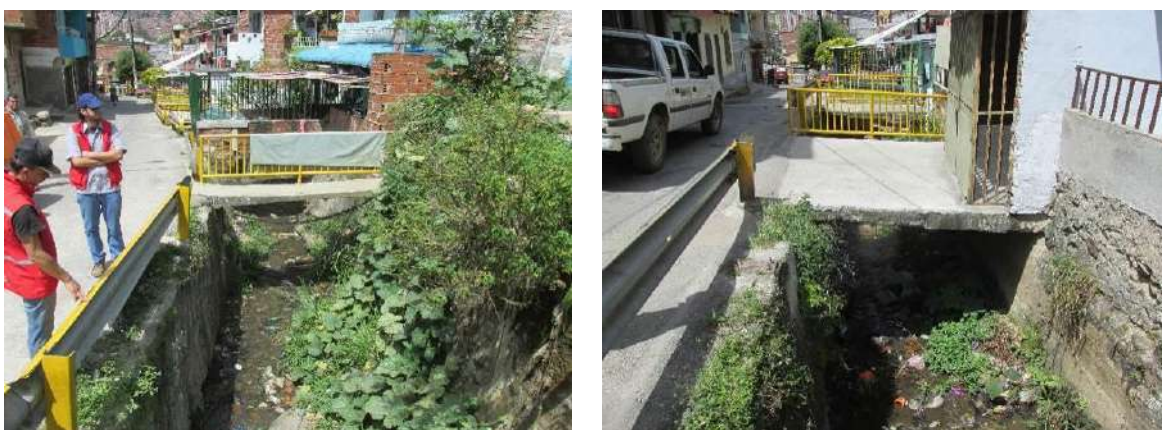
Figura 185. Tramo 3 Canal con paredes en concreto y fondo natural
