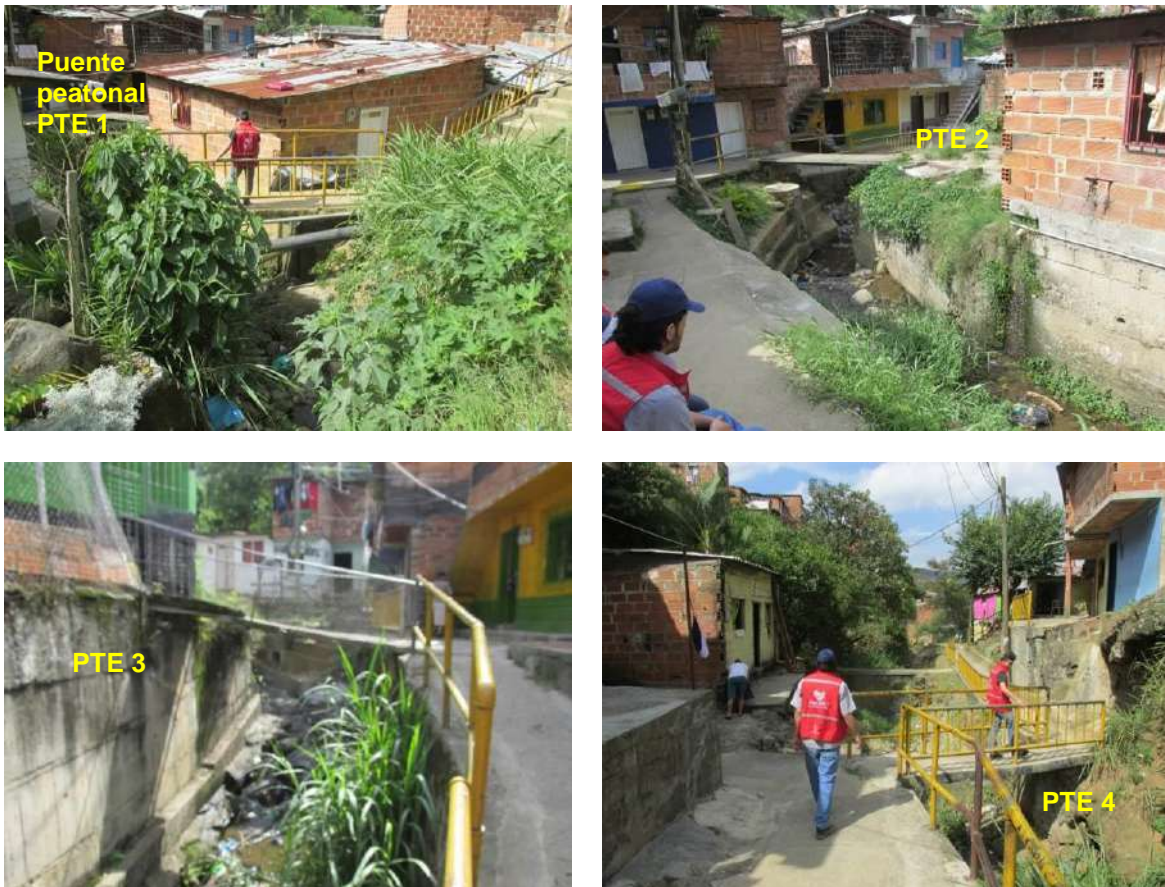
Figura 186. Puentes peatonales 1, 2, 3 y 4 ubicados en el Tramo 1 de la Quebrada La Castro
