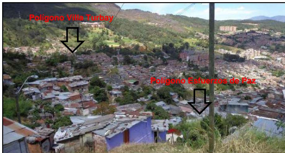
Figura 4. Panorámica general de la zona baja polígonos de Esfuerzos de Paz y Villa Turbay
