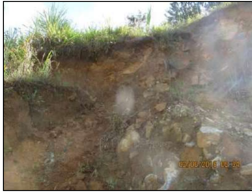
Figura 58. Deslizamientos activos sobre brecha de Dunitas en Polígono Esfuerzos de Paz SFJ06-EP
