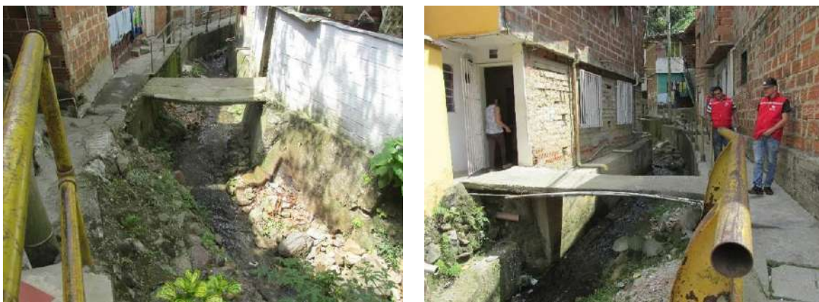
Figura 184. Reducción gradual de ancho en canal con paredes en concreto y fondo natural
