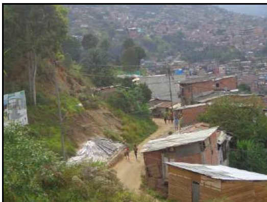
a) Desgarre con evidencias de erosión
