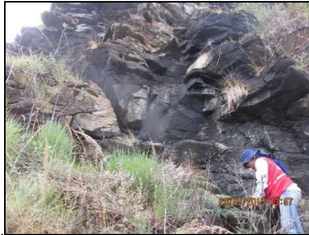
Figura 56. Macizo rocoso con discontinuidades que favorecen la caída
