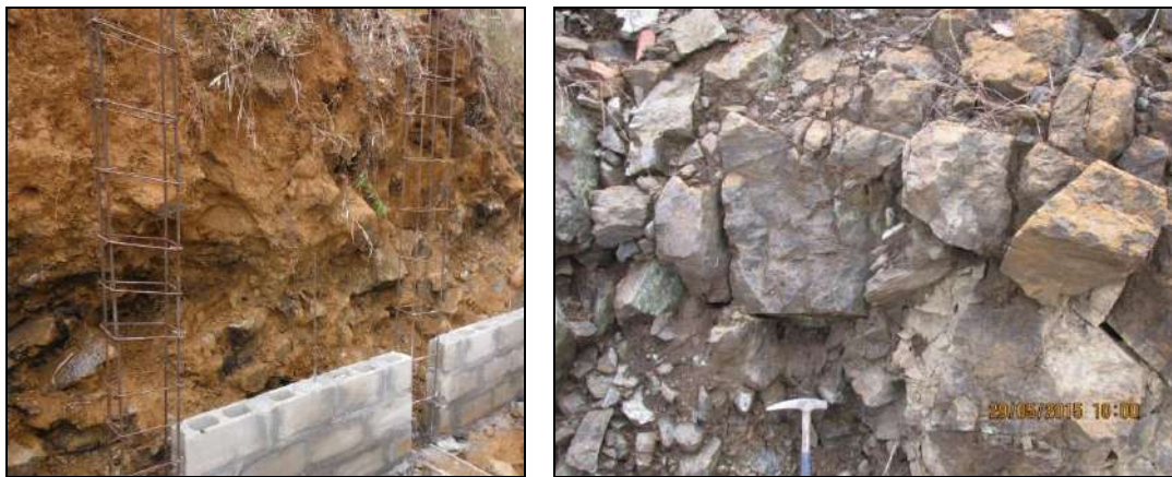
Figura 25. Horizonte IIA de meteorización mostrando bloques de dunitas fuertemente diaclasados
