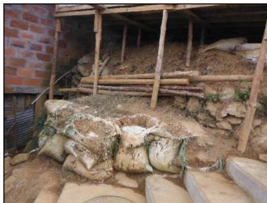
Figura 44. Unidad de Superficie Antrópica AS
