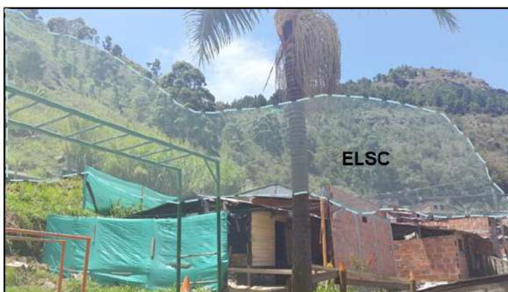
Figura 40. Unidad de Escarpe Largo Semicircular ELSC en la parte alta del polígono
