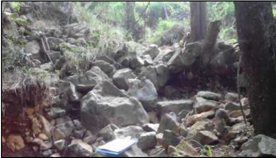
Figura 170. Confluencia de drenaje a la Quebrada La Loca
