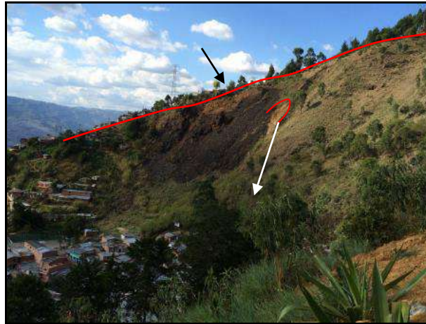
Figura 55. Deslizamiento activo en Estación de Campo MAD03-U-TN
