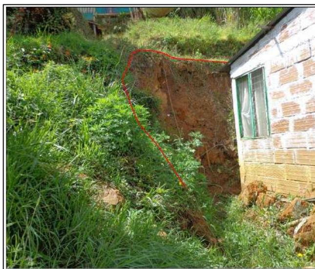
**Figura 41. Desgarre localizado en la parte trasera de una vivienda**
