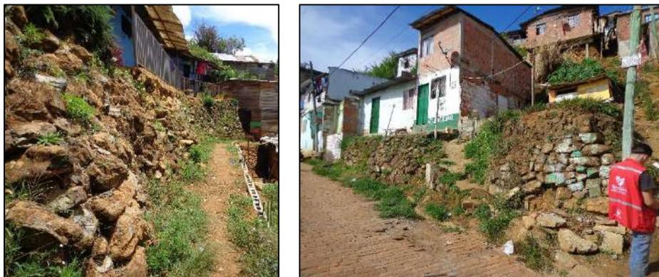
**Figura 9. Llenos con bloque de rocas como base para viviendas**
