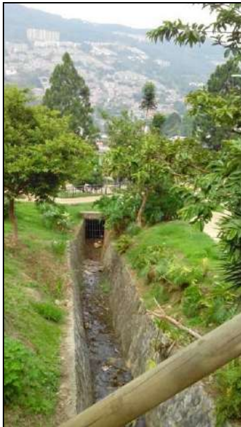
Figura 137. Canalización drenaje Afluente la Loquita
