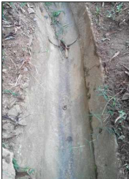
Figura 134. Quebrada La Loquita 1 Subtramo 1 Cuneta semicircular
