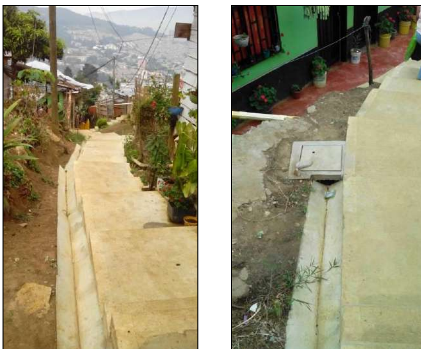
Figura 133. Subtramo 1 Cuneta triangular Quebrada La Loquita 1
