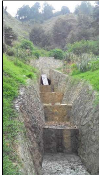
Figura 136. Drenaje Afluente La Loquita Alcantarilla bajo la Calle 56EE
