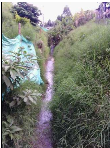
Figura 130. Canal en concreto Quebrada La Loquita Subtramo 3
