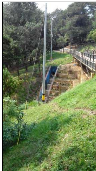
Figura 122. Subtramo 1 Márgenes y canal escalonado
