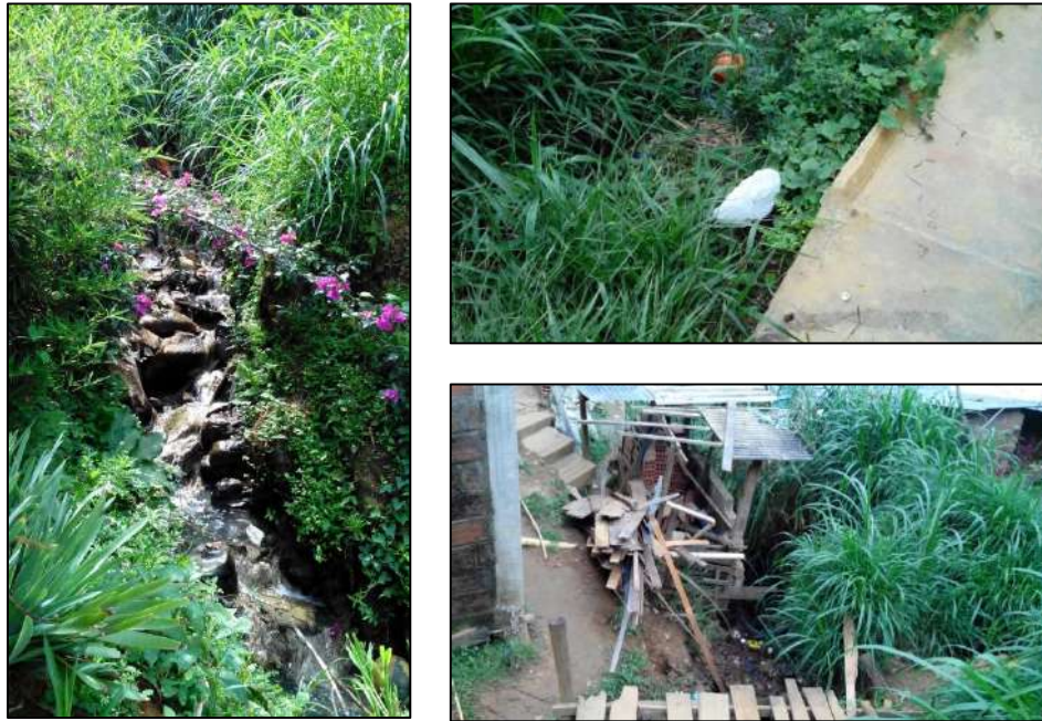
Figura 123. Subtramo 2 Presencia de vegetación en las márgenes del cauce
