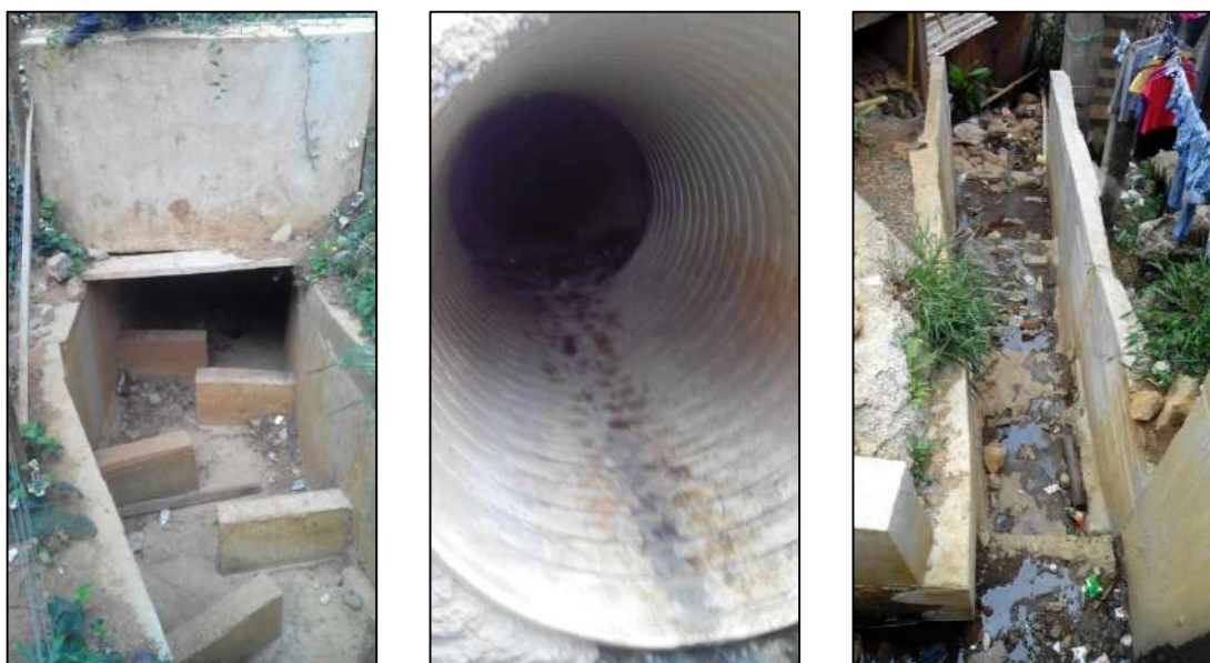
Figura 121. Encole, descole y canal escalonado (Estructura 1) en la salida de la cobertura de la calle 56EE (Estructura 2)
