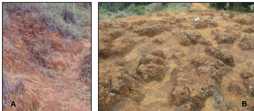
Figura 43. Erosión superficial (A) Surcos y (B) erosión en montículos
