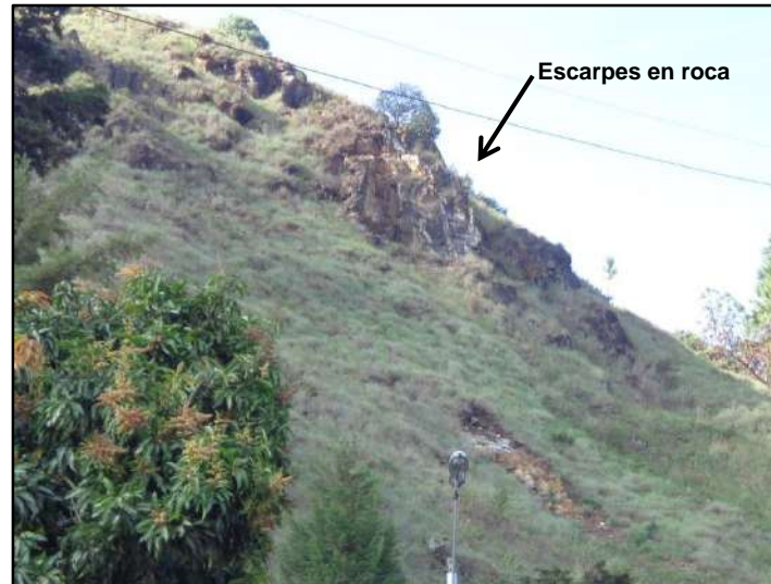
Figura 42. Escarpes de roca en la media de la UMI con alto grado de fracturamiento
