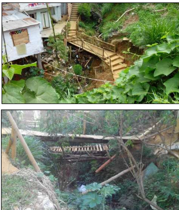
Figura 126. Pasos Peatonales o Puentes No 3 (arriba), 4,5 y 6 (abajo) Quebrada La Gallinaza
