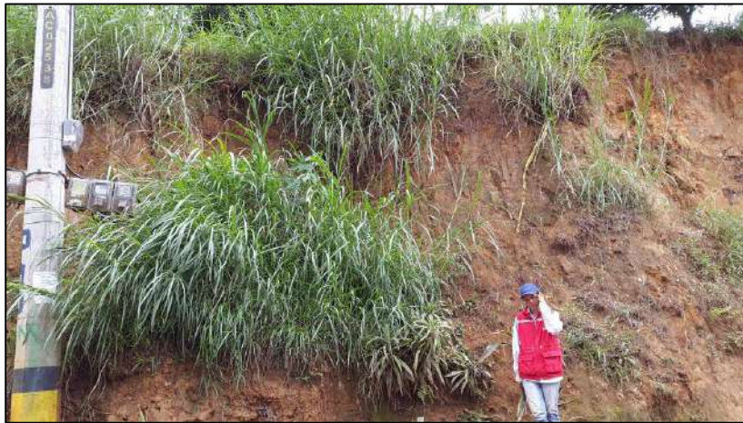
Figura 44. Desgarre cerca de la vía principal de San Antonio
