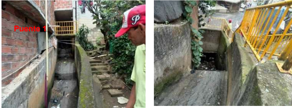
Figura 181. Encole y descole de la Estructura 4 y Puente peatonal 1. Quebrada La Mica 1
