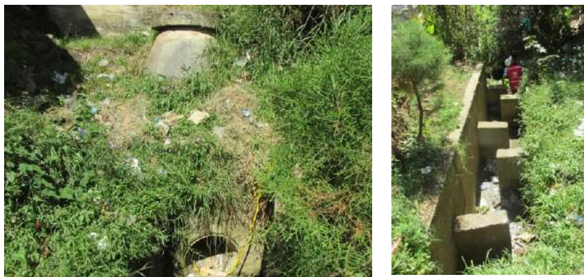
Figura 179. Inicio del tramo de estudio (Manhole) y canal con baffles de fondo.
