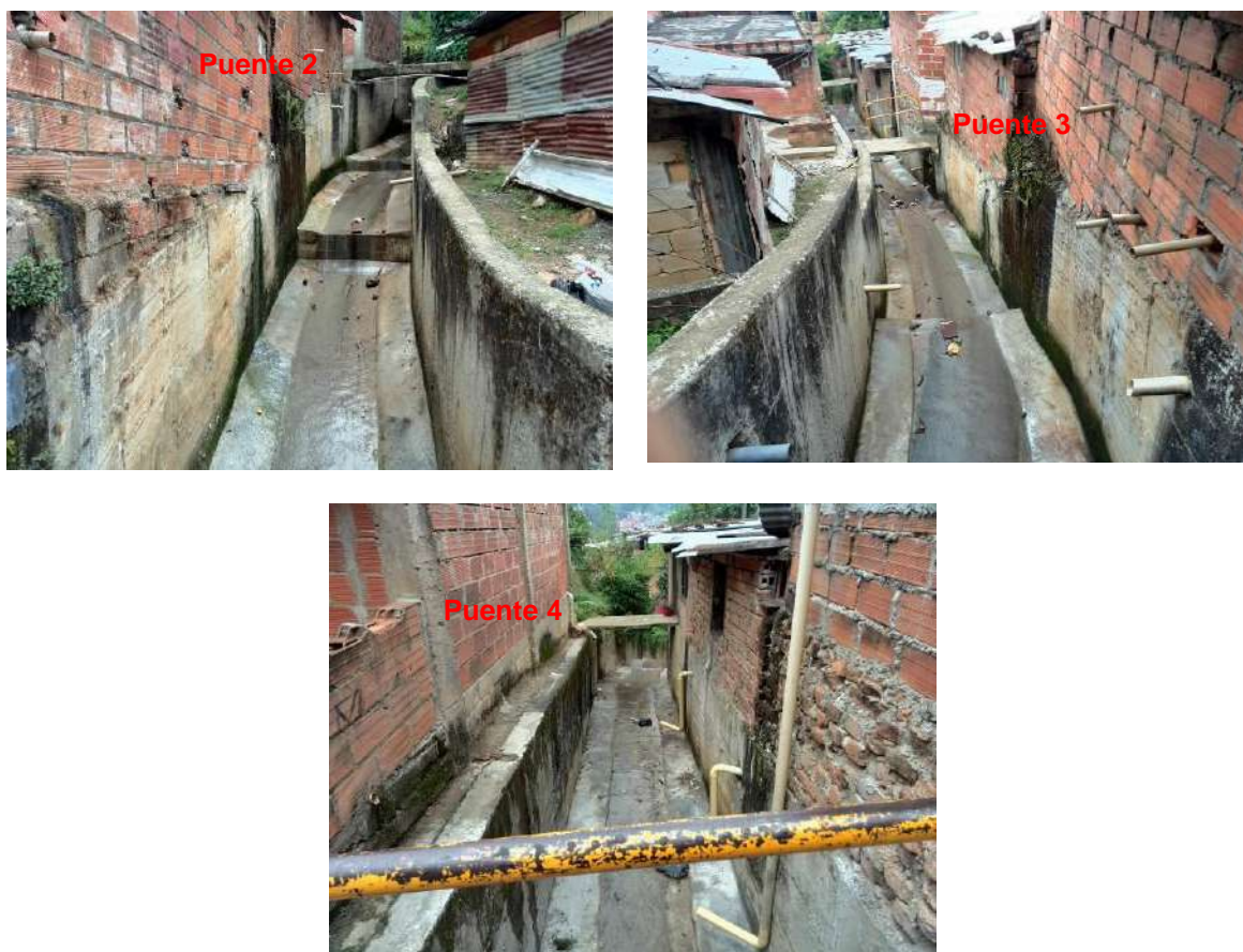
Figura 182. Puentes peatonales 2, 3 y 4 en la Quebrada La Mica 1
