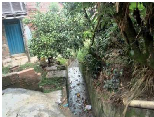
Figura 178. Canal de descarga de la Estructura 1, Quebrada La Mica
