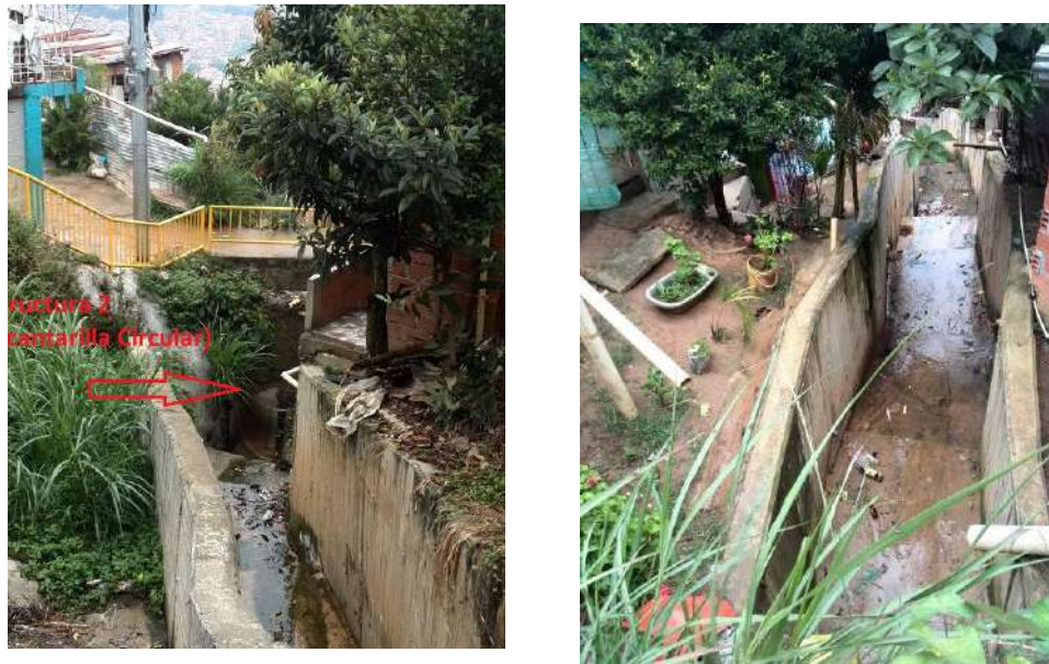
Figura 180. Estructura 2 (Alcantarilla) y Estructura 3 (Canalización). Quebrada La Mica 1
