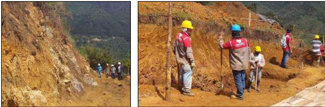
Figura 22. Horizonte IC de meteorización sobre talud
