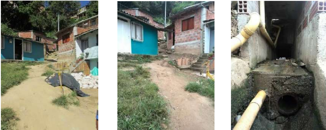
Figura 177. Zona de intervención del cauce (1ra y 2da imagen de izquierda a derecha) y Descole de la Estructura 1 (3ra imagen)
