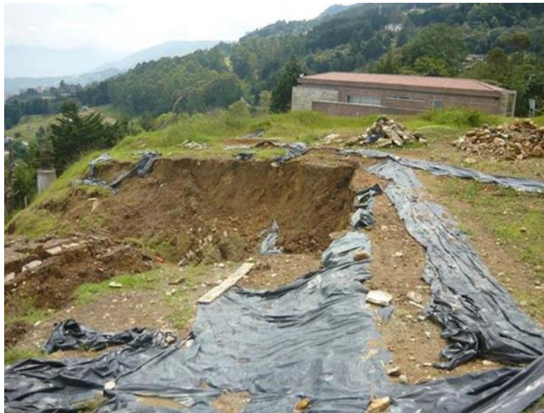
Figura 30. Deslizamiento sobre el lote 44 de la parcelación Mirador de Santa Catalina. Año 2011.
