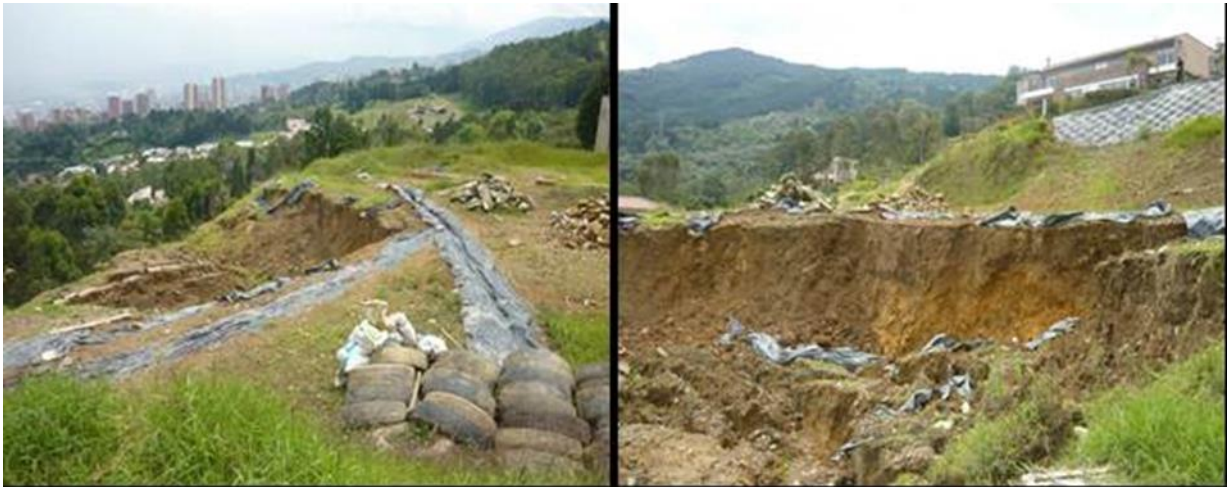
Figura 21. Deslizamiento de tierras lote 44 Mirador de Santa Catalina. Año 2011.
