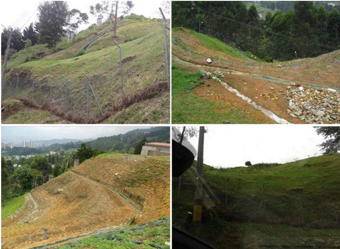
Figura 22. Condiciones actuales sobre el lote en estudio.
