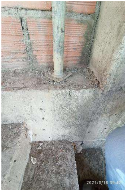
Figura 4: Vigas fisuradas y deficiencias en los procesos constructivos.
