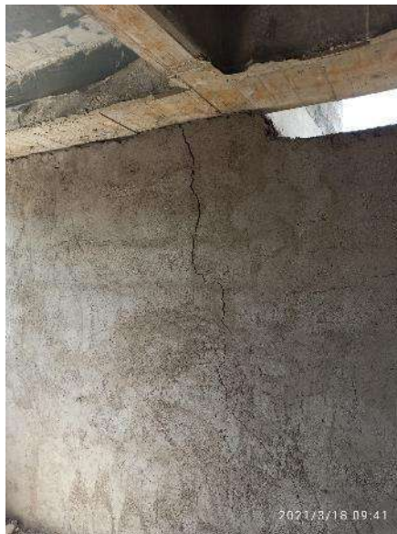
Figura 4: Vigas fisuradas y deficiencias en los procesos constructivos.
