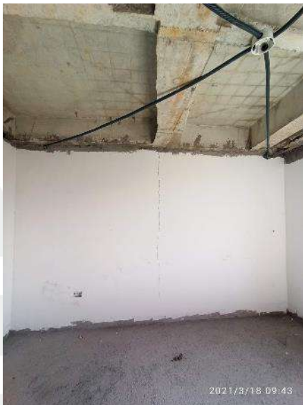
Figura 9: Muros en mampostería fisurados.
