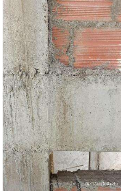
Figura 4: Vigas fisuradas y deficiencias en los procesos constructivos.
