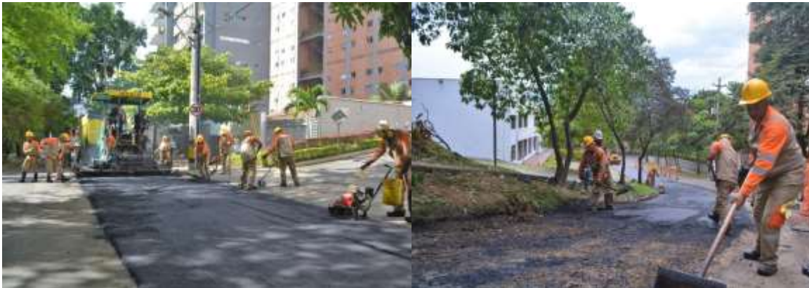
Obras de fresado y repavimentación. Comuna 10. El Poblado. Fuente: Secretaría de Infraestructura Física de Medellín.
