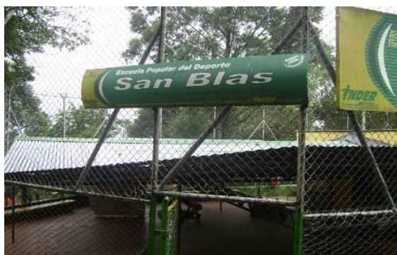
Foto 2 Reconocimiento de Instalaciones Unidad Deportiva.
