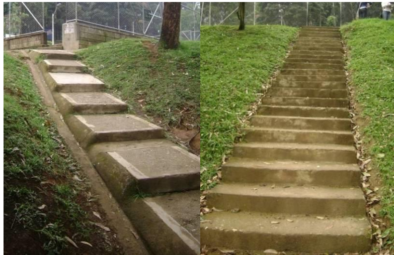
Foto 50. Escaleras Unidad Deportiva
