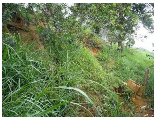
Foto 80 Movimiento en masa de tipo desgarrre superficial.
