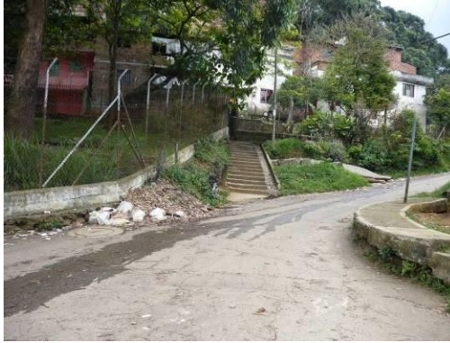
Foto 90 Sector donde confluyen las aguas provenientes de la vía de acceso
