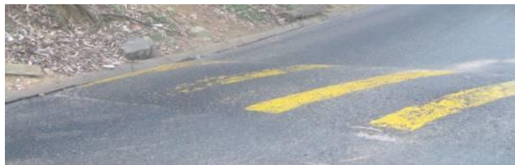
Foto 55. Señalización actual vías en el área de influencia inmediata
