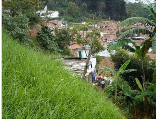
Foto 86 realización de cortes en zonas de alta pendiente
