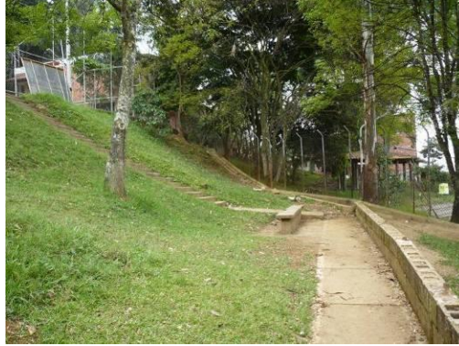
Foto 77 Rango de pendientes 25 - 40%, localizado en el talud inferior de la cancha de microfútbol en arenilla.
