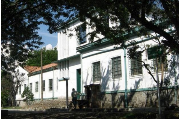
Imagen 13 Edificio antigua Central Metalúrgica - INGEOMINAS
