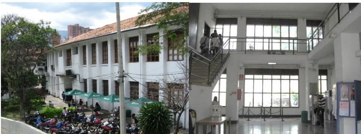
Imagen 14 Izq-Antiguo edificio de la Facultad de Ingeniería Química hoy del CMA- Hall de acceso Imagen 15 Drch-Antiguo edificio de la Facultad de ingeniería Química hoy del CMA
