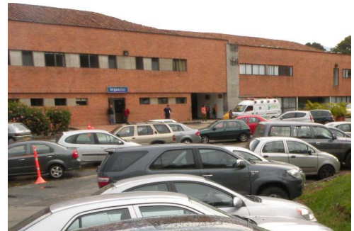
Imagen 15. Accesos al Edificio.
